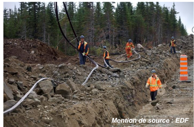
Figure 2. Assemblage d'une éolienne (gauche) et installation d'un réseau collecteur souterrain (droite)
