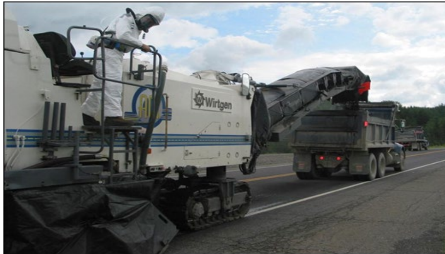
Figure 4 – Enlèvement des enrobés amiantés à l'aide de la technique « planage-stabilisation »
