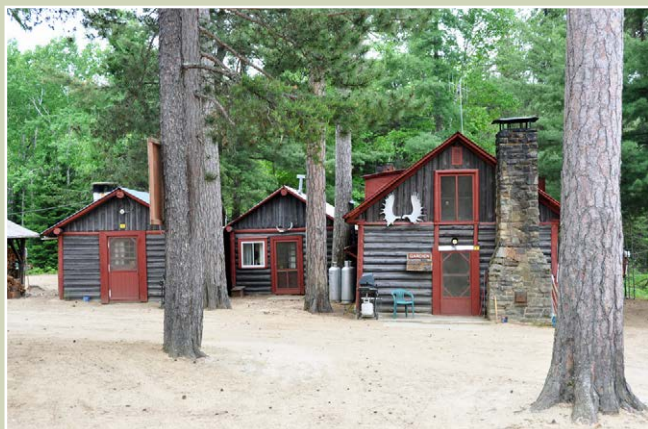
Photo 46. Bâtiments de la pourvoirie J. E. Goyette sur les rives du lac Gaucher, à la limite ouest de la RBP du Canyon-de-la-Rivière-aux-Rats (J. Dubé Marcoux, MDDEP)
