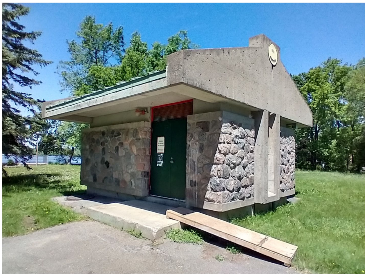
Photo 1: la station de pompage de l'émissaire Curotte dans le parc Louis-Hébert (photo de l'auteur).
