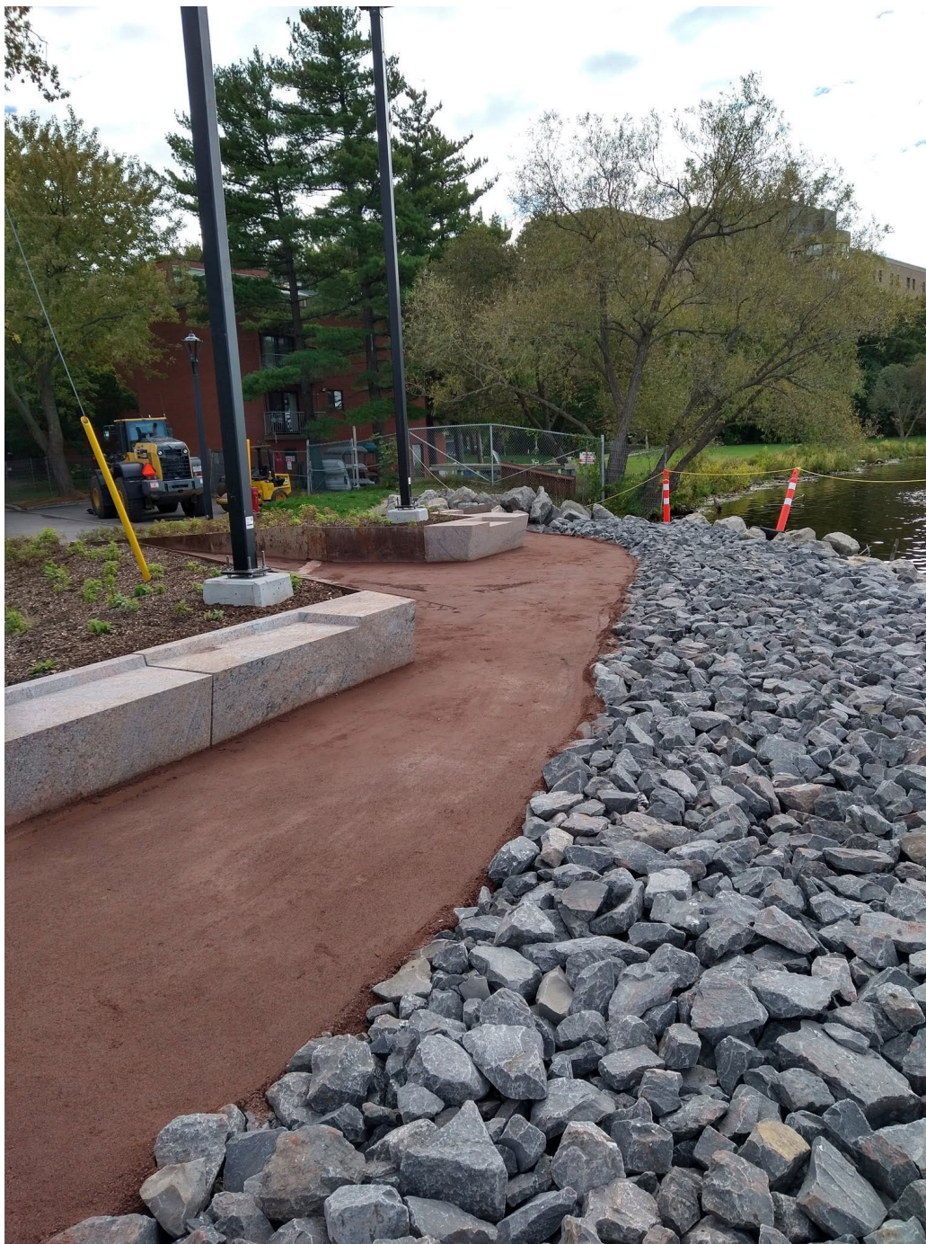
Photo 11. Remblai reconfiguré à la placette Fort-Lorette en 2023 : le niveau de l'enrochement a été abaissé et la partie plate sur le dessus permet aux personnes d'y circuler, pêcher, bavarder, méditer. L'espace comprend aussi une bande de végétation. La pente brise-glace se compose de roches d'une granulométrie plus petite que celles placées dans la phase 1. (Photo de l'auteur).
