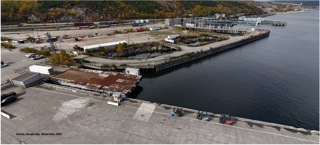
Photo 3.1.1 : Vue sur le terminal n° 5 actuel
