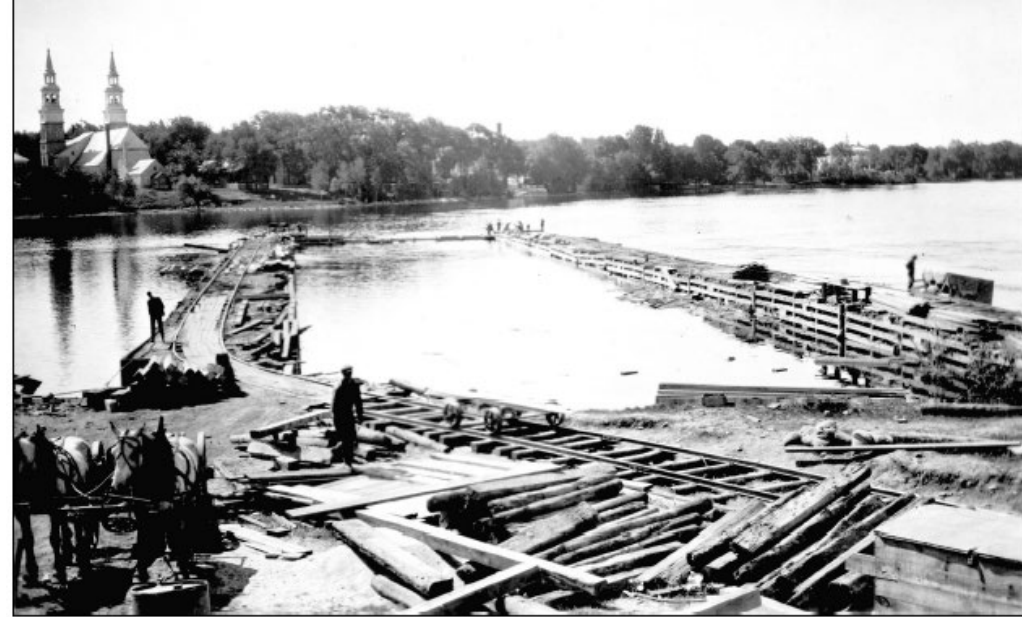
Figure 6 - La construction de la digue Simon-Sicard (HQ F09-700759-04).
