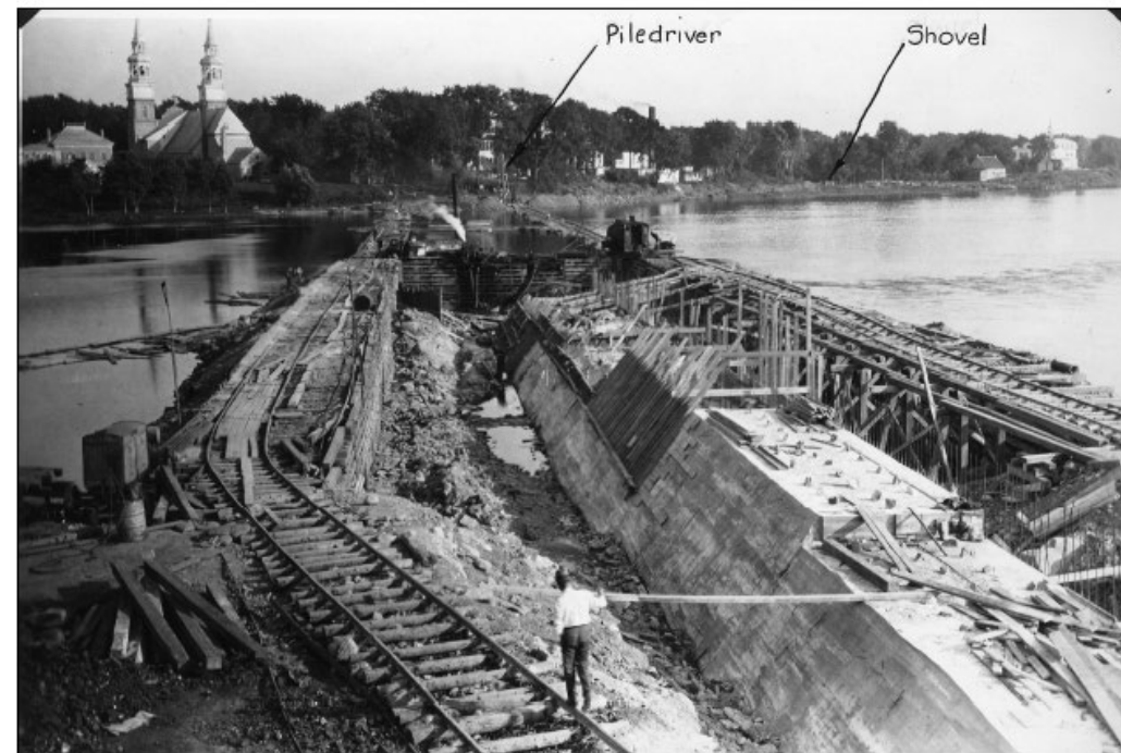
Figure 6 - La construction de la digue Simon-Sicard (HQ F09-700759-04).
