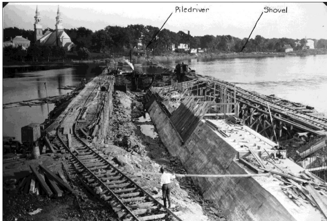
Construction plus avancée de la digue Simon-Sicard. Les caissons semblent avoir servi à la construction du rail sur la droite qui s'étendra ensuite sur la rive (HQ F09-701245-55-295).
