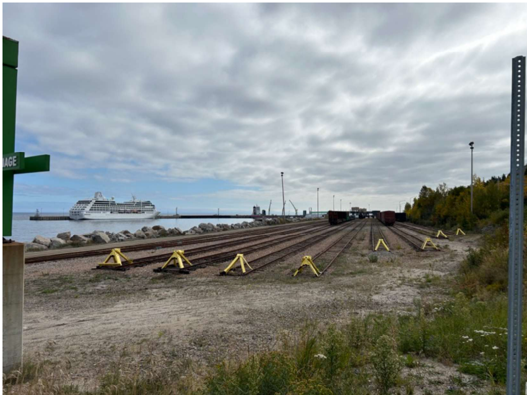
Figure 5-1 : Aperçu des activités portuaires au nord de la gare ferroviaire
