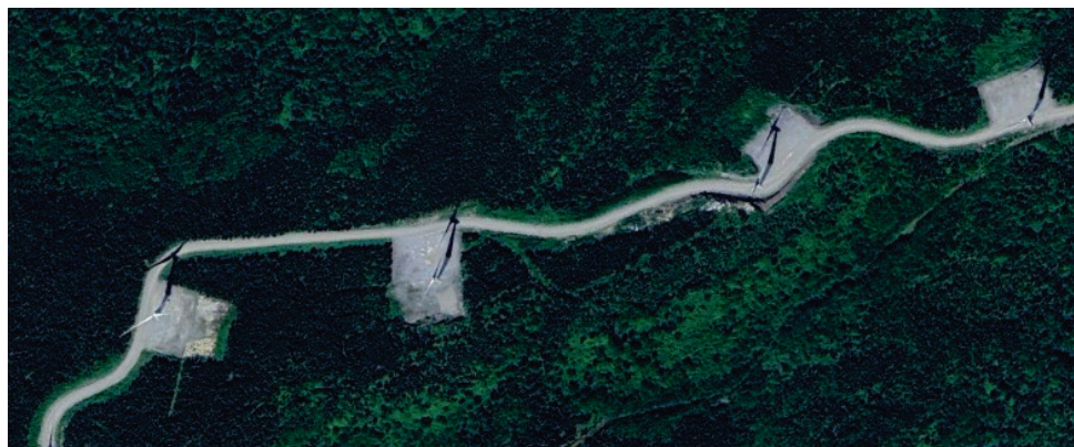
Exemple de parc éolien au Bas-Saint-Laurent qui regroupe l'emplacement de ses éoliennes à proximité du chemin afin de réduire au minimum l'empiétement dans les milieux naturels.
