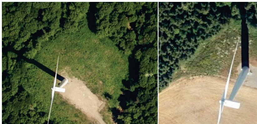
Exemple de parc éolien au Bas-Saint-Laurent qui permet d'illustrer que la base des éoliennes peut être revégétalisée sans qu'il y ait d'atteinte aux usages fonctionnels de la structure.
