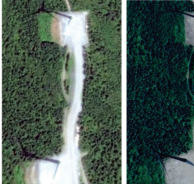
Exemple de parc éolien au Bas-Saint-Laurent pour lequel une section de l'emprise associée à l'installation de la structure a été revégétalisée (empiètement temporaire).
