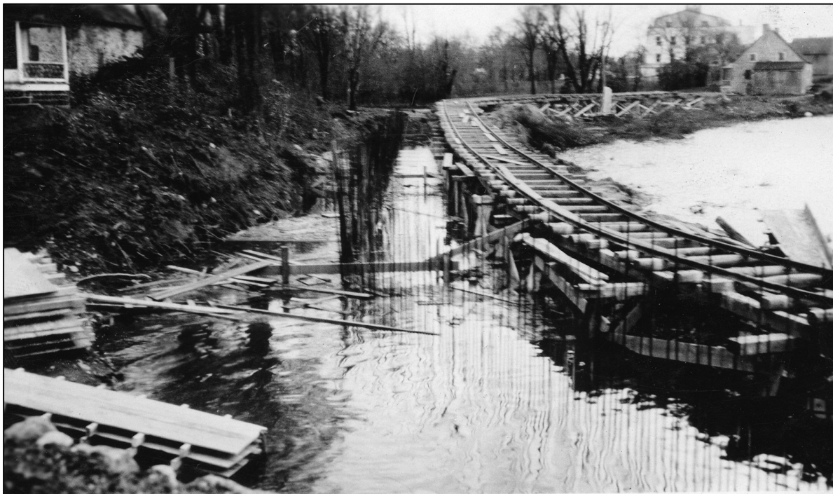
Figure 9 - Érection du mur de béton directement sur la rive sans creusement de sillon ou d'installation d'un système de rails près du pensionnat des Sœurs de la Miséricorde et de la maison Saint-Janvier (HQ F09-701245-2).
