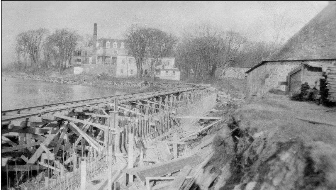
Figure 8 - Installation d'un rail sur la rive qui se rend jusqu'à la digue Simon Sicard. La structure permet également la construction du mur de soutènement. À l'arrière-plan, on aperçoit le pensionnat des sœurs de la Miséricorde (HQ F09-701425-55-318).
