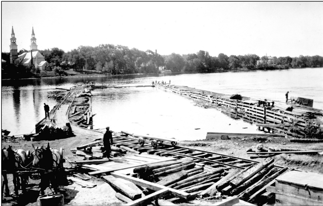
Figure 6 - La construction de la digue Simon-Sicard (HQ F09-700759-04).
