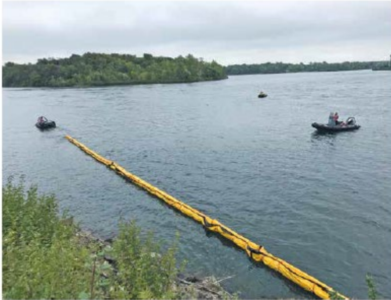
Installation d'un rideau de turbidité pour confiner les sédiments (HQ 2022).
