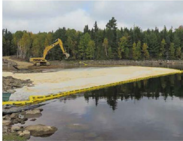
Installation d'un rideau de turbidité pour confiner les sédiments (HQ 2022).
