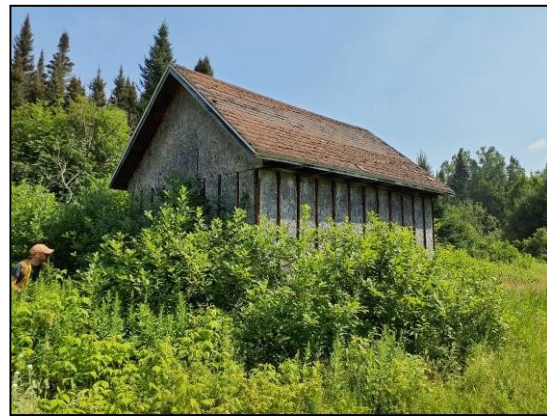
Figure 12 Cabane au nord-est de la zone A10, vue vers l'est (photographie PPAW2_019)
