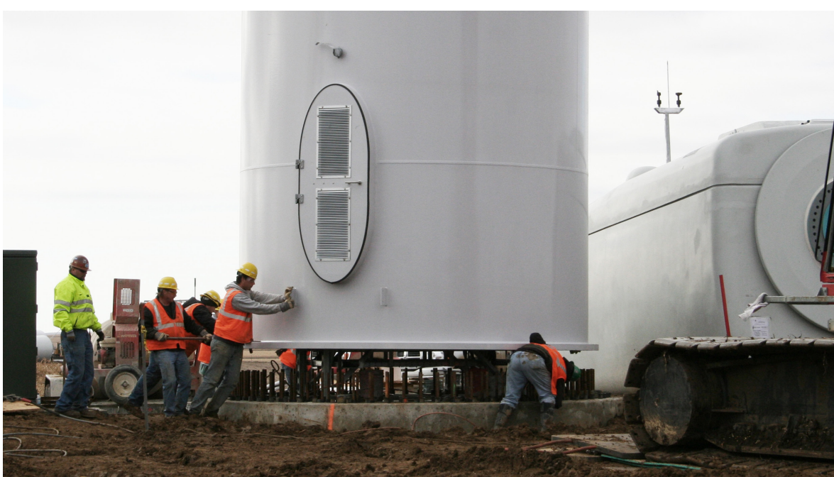
Étape 5: Fixation de la base à la fondation
