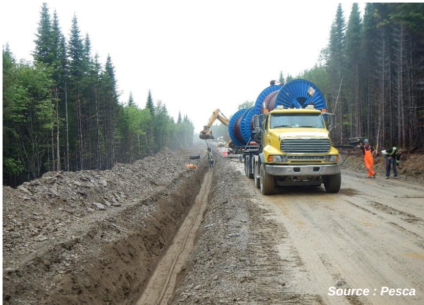
Figure 12. Installation d'un réseau collecteur souterrain
