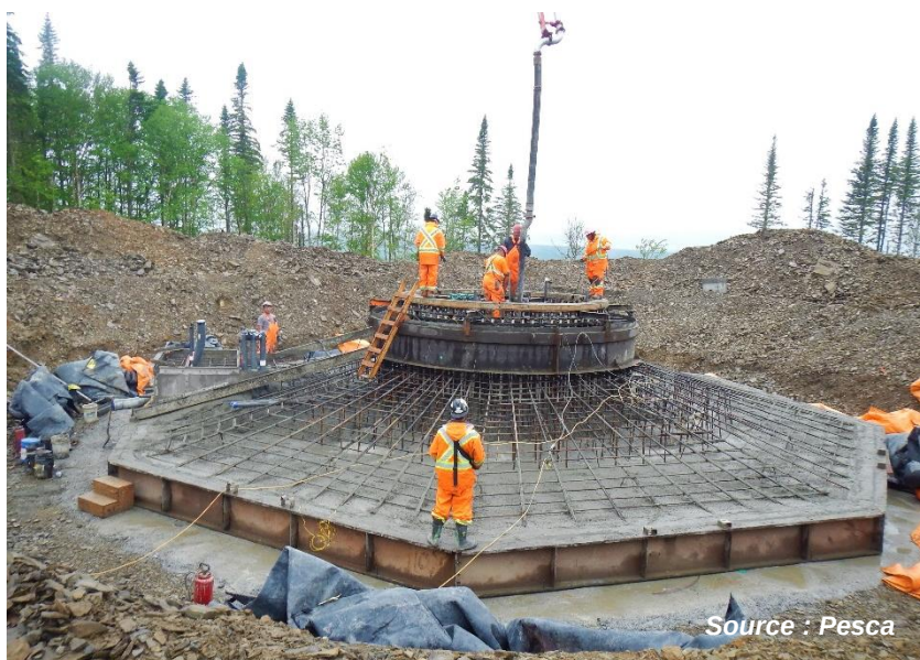
Figure 10. Construction d'une fondation d'éolienne circulaire
