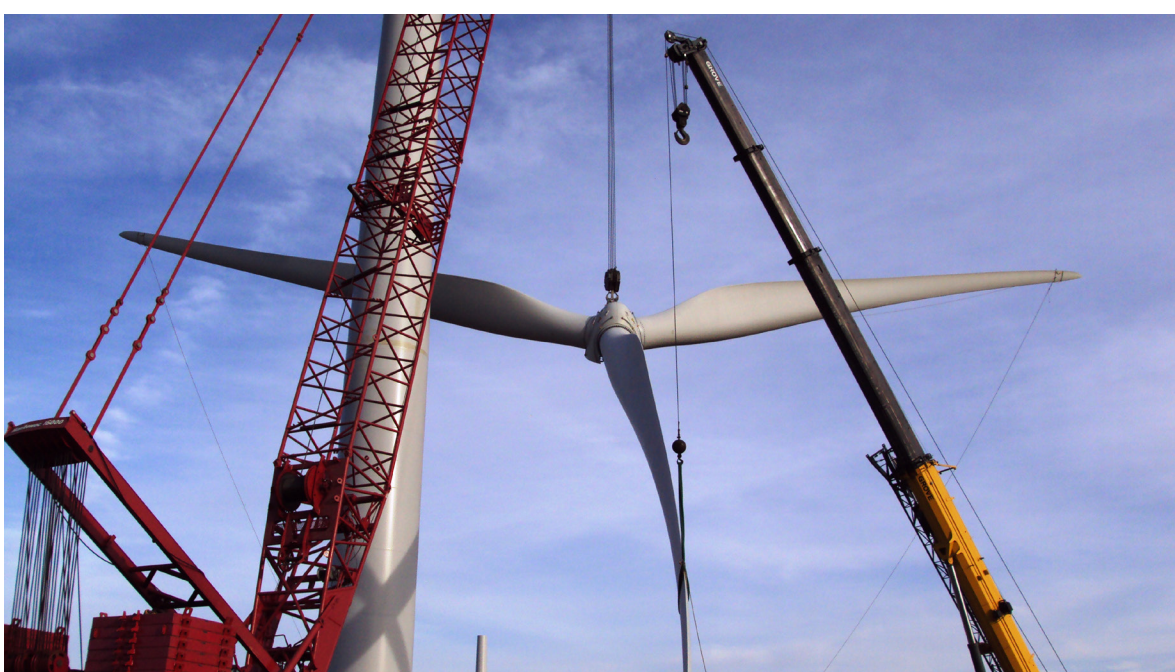
Étape 7: Installation de la nacelle et des pales
