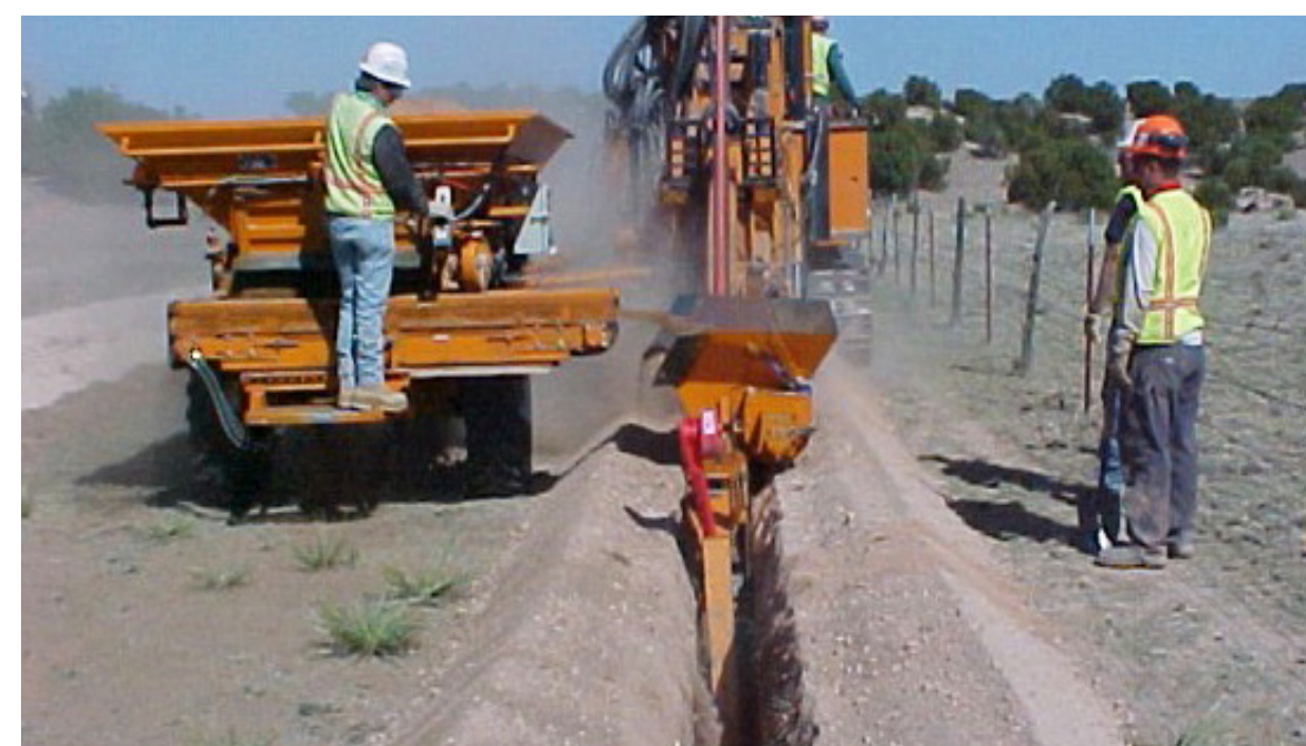
Étape 8: Enfouissement des câbles souterrains
