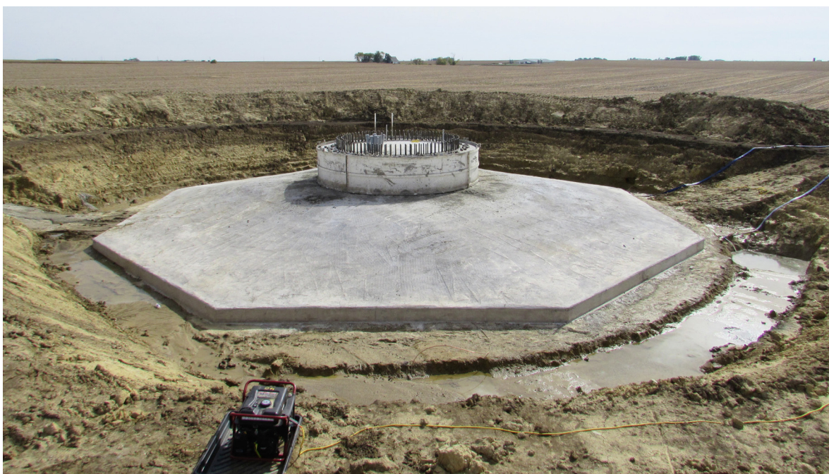
Étape 3: Coulage du béton
