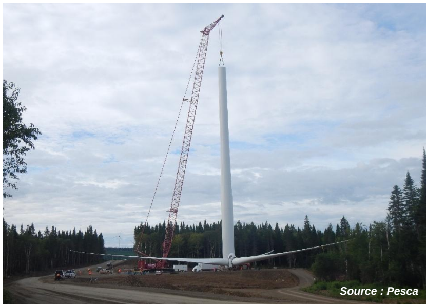
Figure 11. Assemblage d'une tour d'éolienne par section
