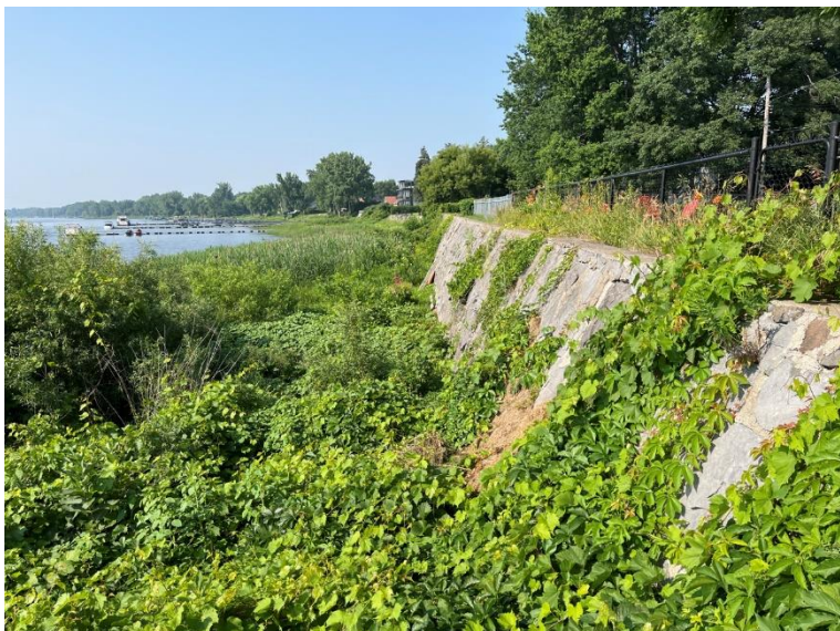
Photo 5 Mur de soutènement en pierre des champs
