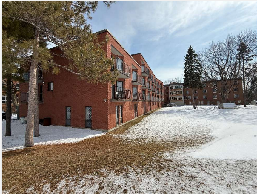
P16. Vue sur la cour arrière de la résidence Ignace Bourget (12 350, rue du Fort-Lorette, lot 2 494 709).
