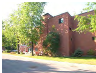
Résidence Ignace-Bourget. Vue latérale
