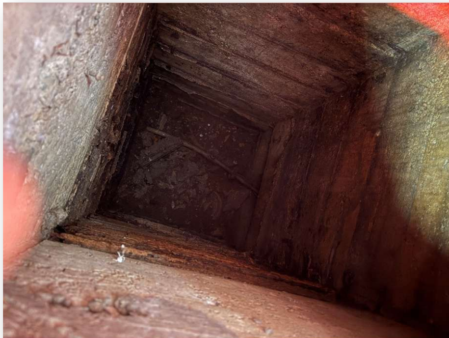
P2. Vue du trou d'homme (~ 2m de profondeur) au 1 395 boulevard Gouin est.
