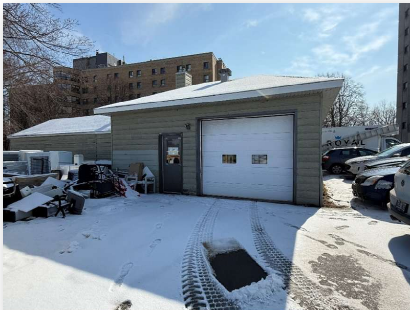
P10. Vue sur le bâtiment (remise) au lot 2 736 254 avec entreposage sur asphalte d'appareils électroniques / électroménagers pour fins d'élimination/valorisation.
