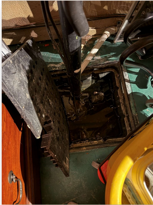
P3. Vue du puisard au 1 395 boulevard Gouin est.
