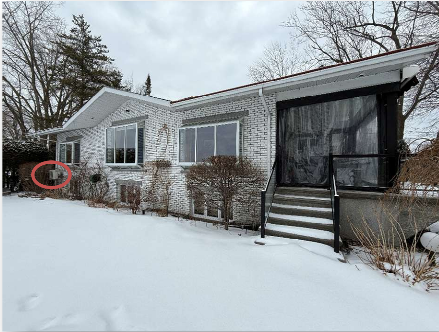
P1. Vue de la façade arrière du 1 395 boulevard Gouin est (lot 2 496 750) avec une thermopompe.
