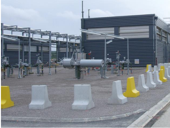
Muret de béton (sotubema.com)
