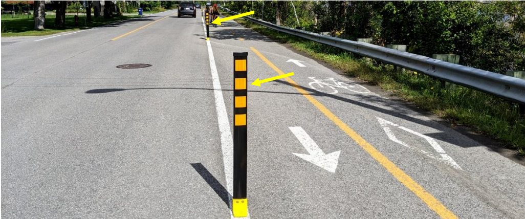
Figure 31 Exemple de bande cyclable bordée de balises flexibles 4
