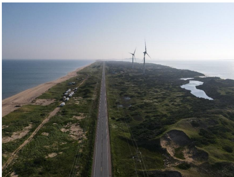
FIGURE 1. PARC EOLIEN DE LA DUNE-DU-NORD (VUE AERIENNE) @ATTENTION FRAGÎLES
