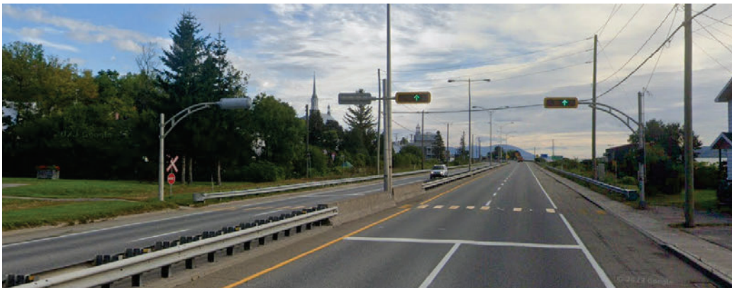
Figure 3-14 : Exemple boulevard Sainte-Anne : terre-plein avec glissière rigide médiane
