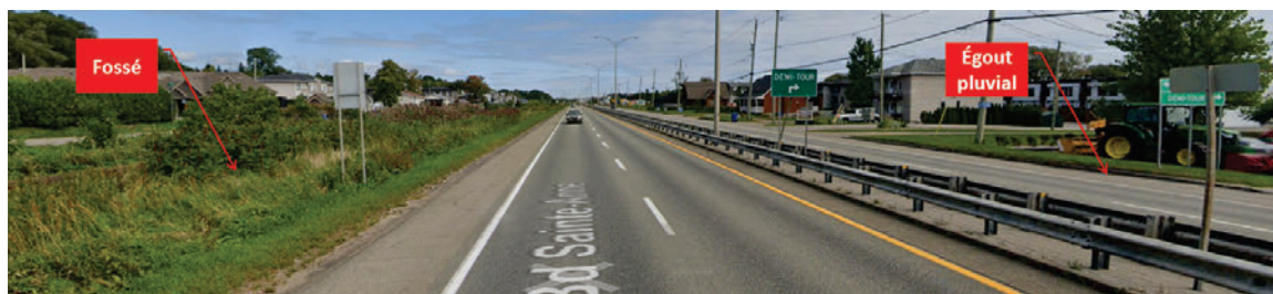
Figure 3-16 : Exemple boulevard Sainte-Anne : drainage
