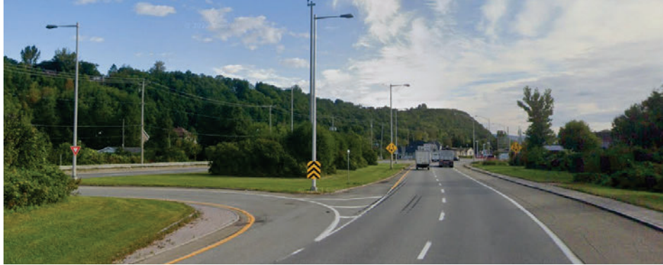
Figure 3-10 : Exemple boulevard Sainte-Anne : terre-plein gazonné avec virage en « U »
