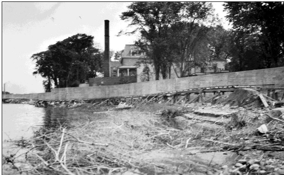
Figure 20 - Avancement des travaux de la digue Simon-Sicard. On voit au pied de la structure les enrochements et la présence des rails. La hausse du niveau de l'eau (3-4m) suite à la construction du barrage aurait couvert l'ensemble des aménagements (F09-701245-3).
