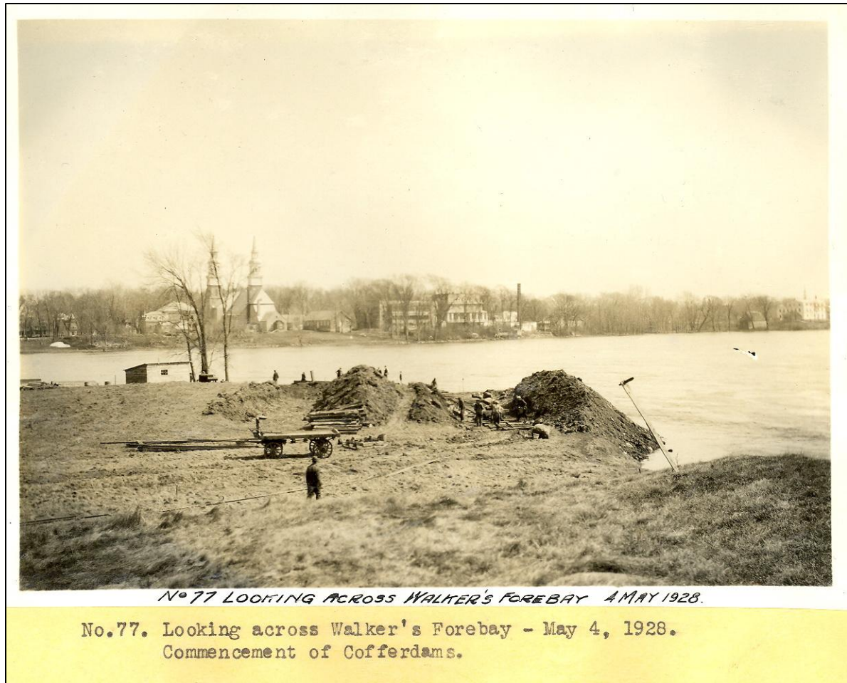
Figure 3 - L'emplacement du barrage Simon-Picard depuis l'Île de la Visitation en 1928 avant le début des travaux (HQ F09-701245-77).
