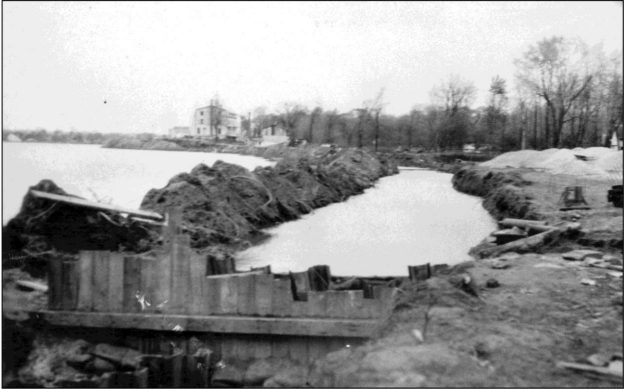
Figure 6 - Construction du mur de soutènement depuis la terre ferme en 1928 (HQ F09-701245-55).
