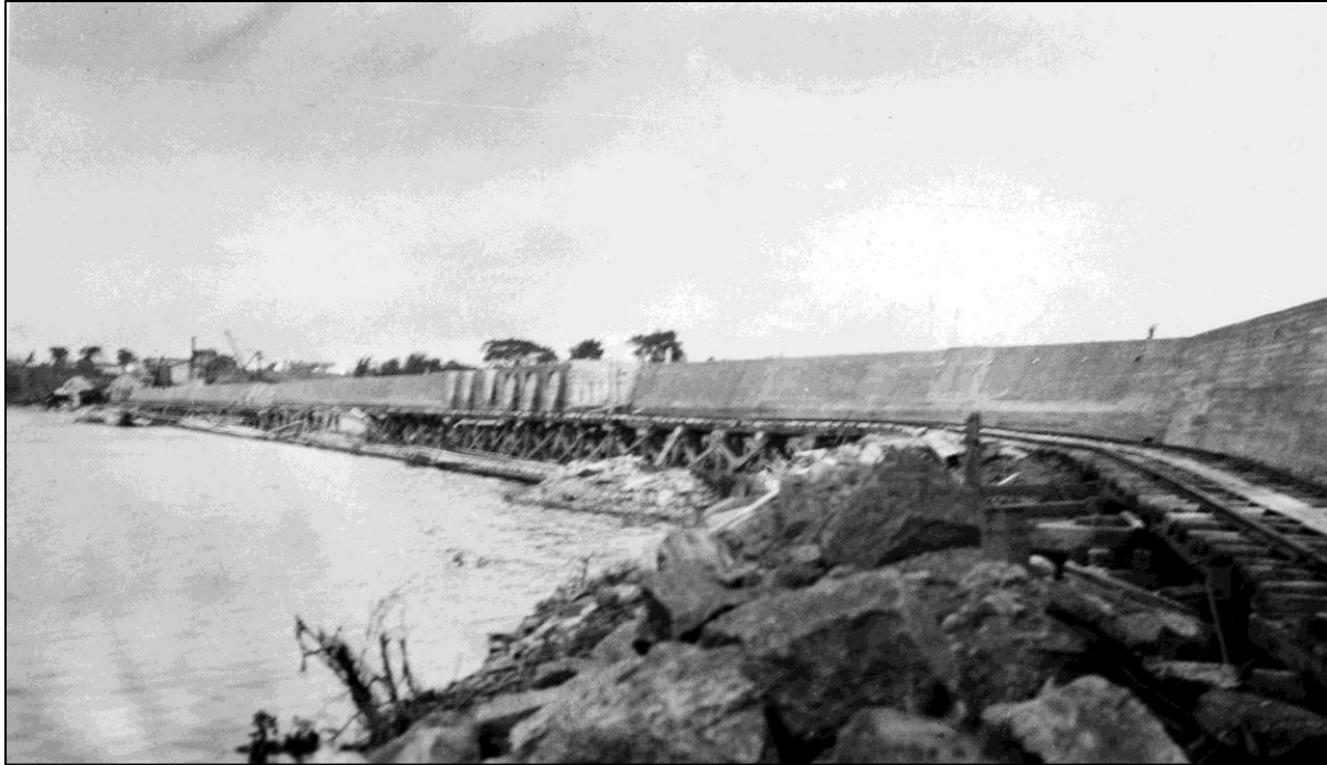
Figure 19 - Creusement du sillon pour la construction du mur de soutènement et le système d'égout près de la rive et à partir de la terre (HQ F09-701245-9).
