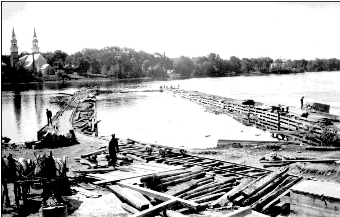
Figure 15 - La construction de la digue Simon-Sicard (HQ F09-700759-04).
