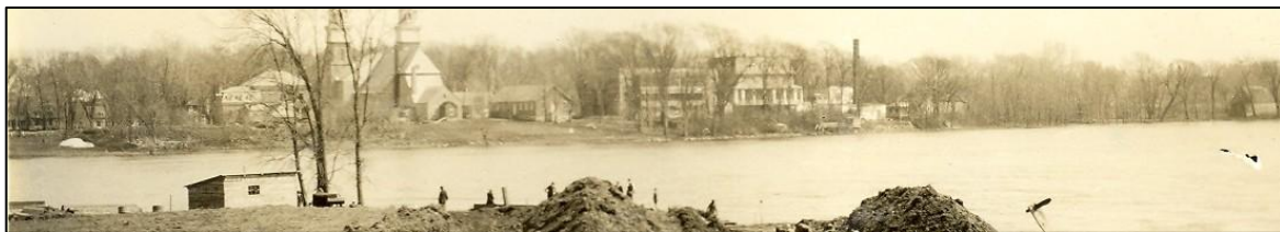
Figure 14 - Extrait d'une photographie (figure 2) prise depuis l'île de la Visitation sur les lieux de la construction du barrage Simon-Sicard. Aucune structure ne semble présente sur la rive (HQ F09-701245-77).
