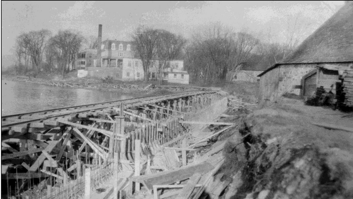
Figure 17 - Installation d'un rail sur la rive qui se rend jusqu'à la digue Simon Sicard. La structure permet également la construction du mur de soutènement. À l'arrière-plan, on aperçoit le pensionnat des sœurs de la Miséricorde (HQ F09-701425-55-318).
