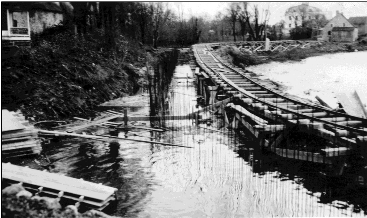
Figure 18 - Érection du mur de béton directement sur la rive sans creusement de sillon ou d'installation d'un système de rails près du pensionnat des Sœurs de la Miséricorde et de la maison Saint-Janvier (HQ F09-701245-2).
