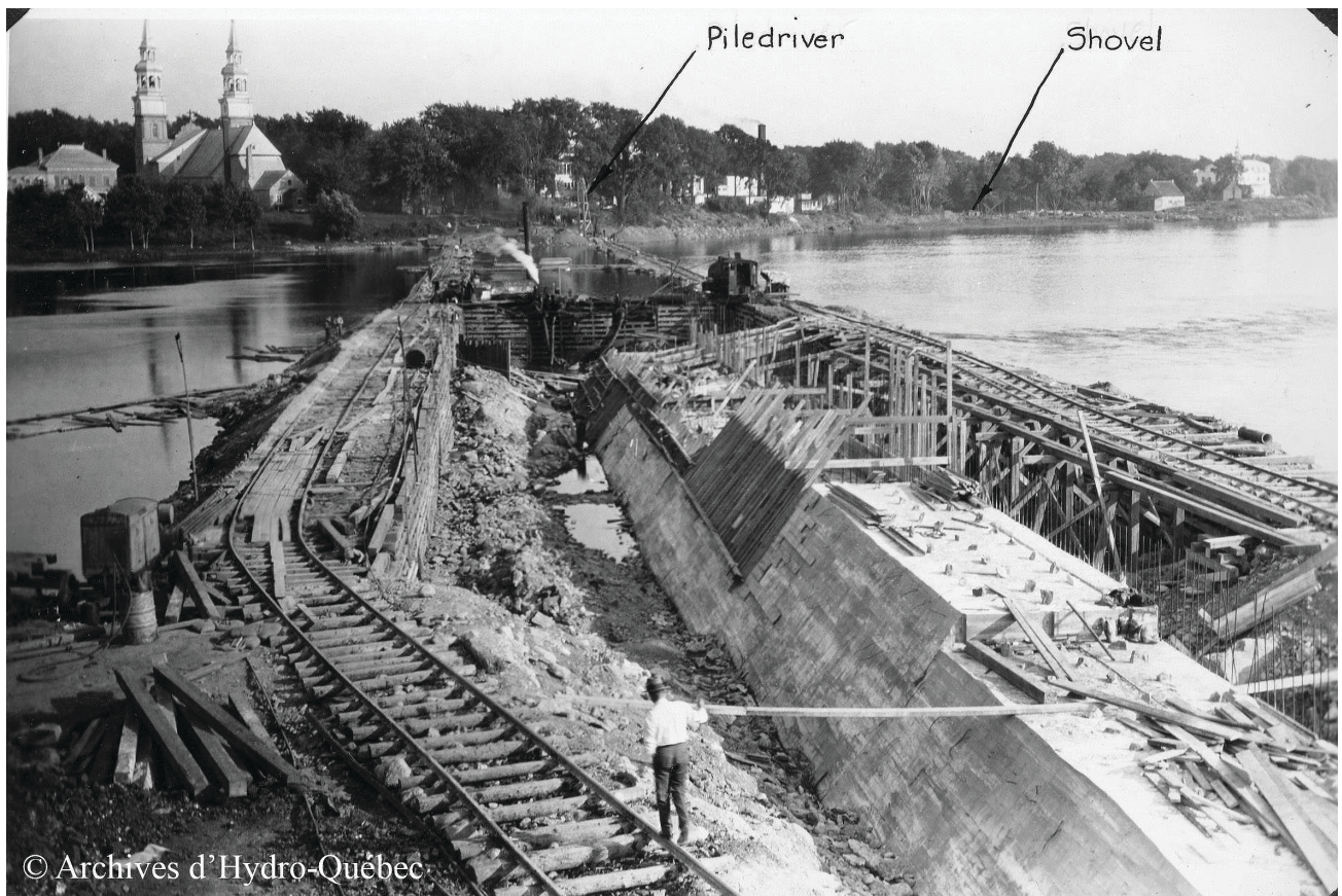
Figure 12 – Photos de 1928 permettant d'observer le talus à l'arrière de l'aire d'étude (Archives d'Hydro-Québec)
