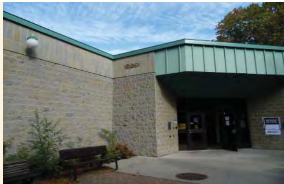
Entrée du centre sportif de la Ville de Montréal Photo : Passerelles coopérative en patrimoine
