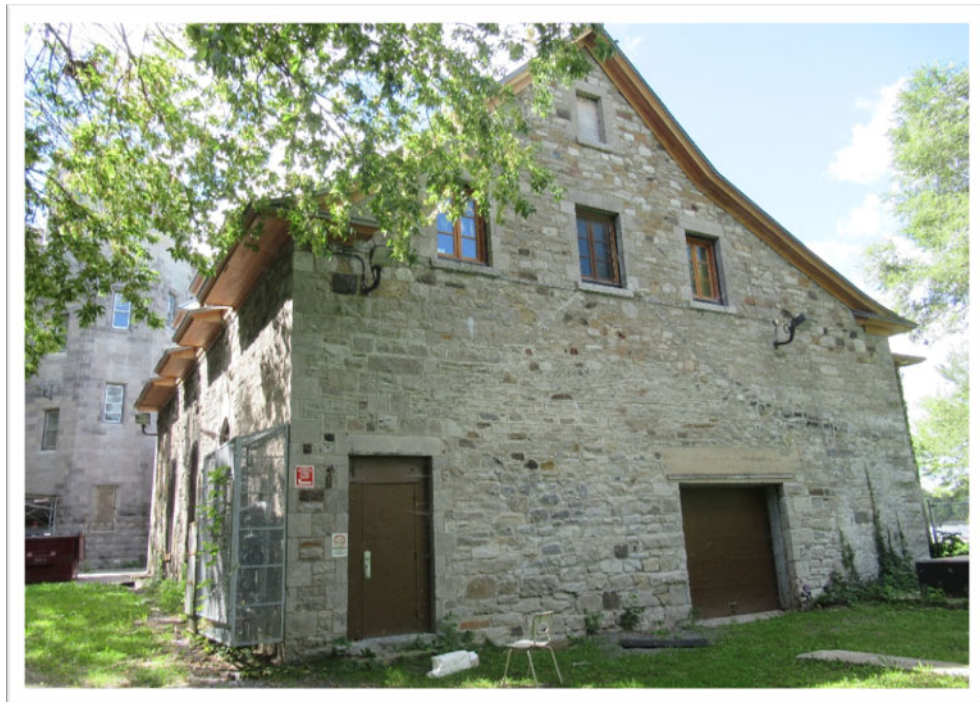
PHOTO 14 — Vue vers l'ouest du bâtiment annexe de la chaufferie de l'école Sophie-Barat, situé à l'extrémité est du bâtiment principal de l'école.
