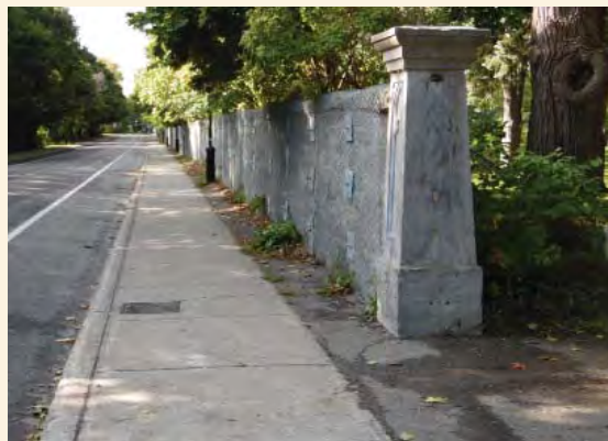
Mur d'enceinte sur le boulevard Gouin Est
