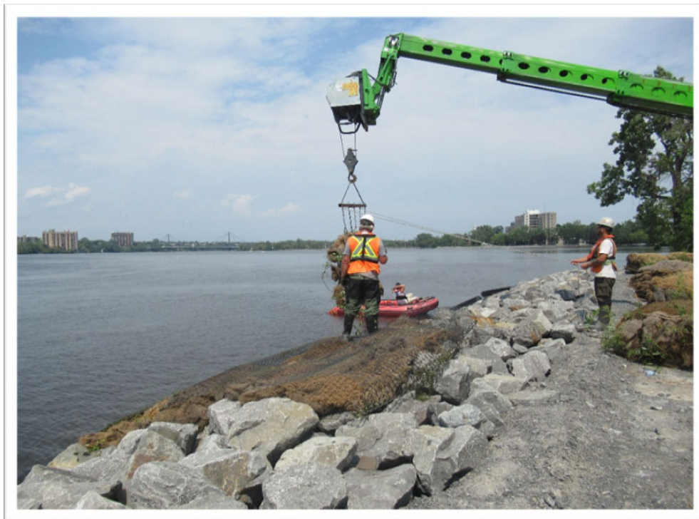
PHOTO 3 — Vue vers l'est de l'aménagement de la bande riveraine, à travers la replantation d'herbier aquatique le long de la rive située dans le secteur de l'école Sophie-Barat.
