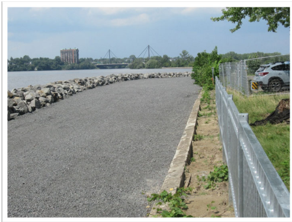
PHOTO 7 — Vue vers l'est de la section du mur de soutènement (incluant le remblai d'enrochement) située dans le secteur de la résidence Berthiaume-Du Tremblay (secteur est du site à l'étude).
