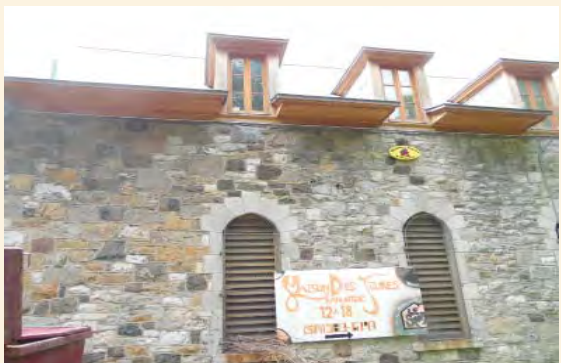
La chaufferie lors de son usage par la Maison des jeunes Source : Passerelles coopérative en patrimoine
