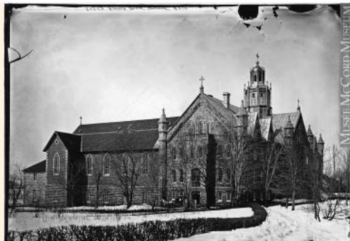
L'ancien pavillon principal, incendié en 1929 Photo : Musée McCord
