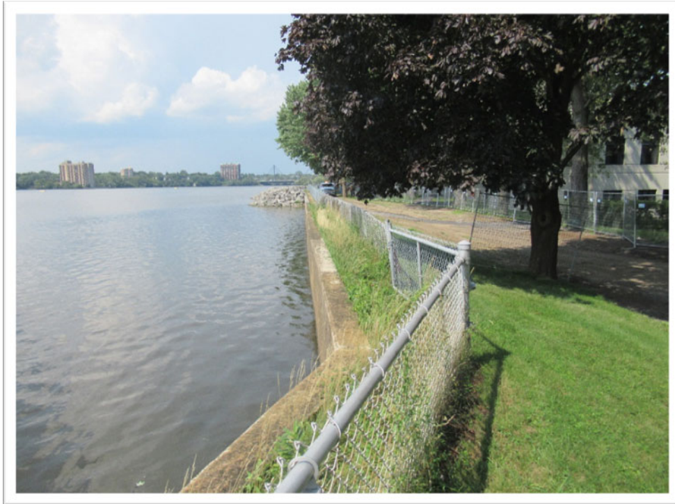
PHOTO 5 — Vue vers l'est de la section du mur de soutènement située dans le secteur de la propriété des Frères de Saint-Gabriel (lot 2 495 539).
