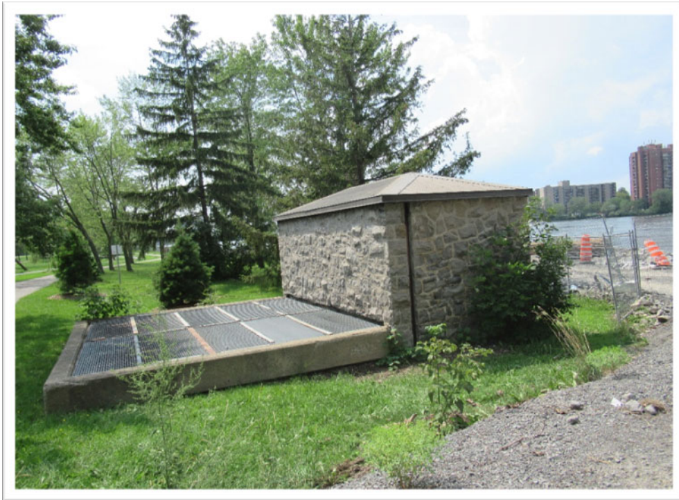
PHOTO 13 — Vue vers l'ouest de l'édicule de ventilation du garage souterrain de la STM, situé dans la partie nord-est de la propriété de l'école Sophie-Barat.
