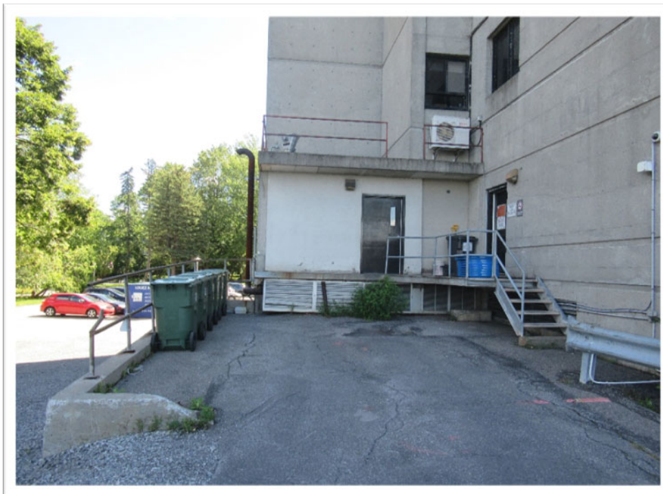
PHOTO 20 — Vue vers le sud des bacs de récupération des matières résiduelles entreposés, à l'extérieur, sur une surface asphaltée dans la portion nord-est du bâtiment du CHSLD Berthiaume-Du Tremblay.
