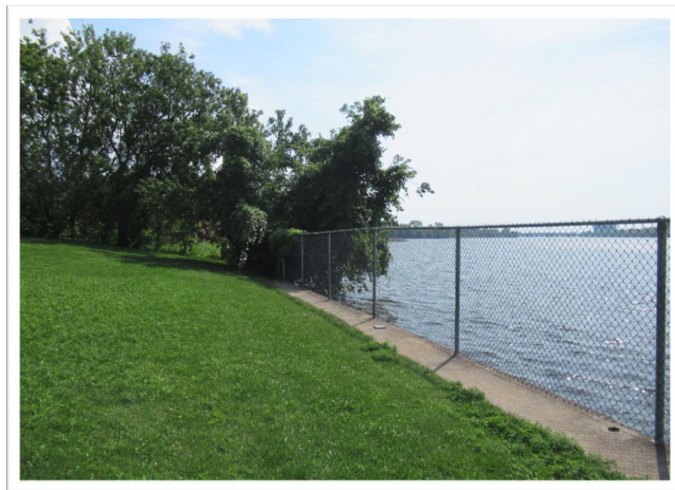
PHOTO 12 — Vue vers l'ouest de la section du mur de soutènement située à la limite nord de la propriété abritant l'Église de la Visitation (secteur est du site à l'étude).
