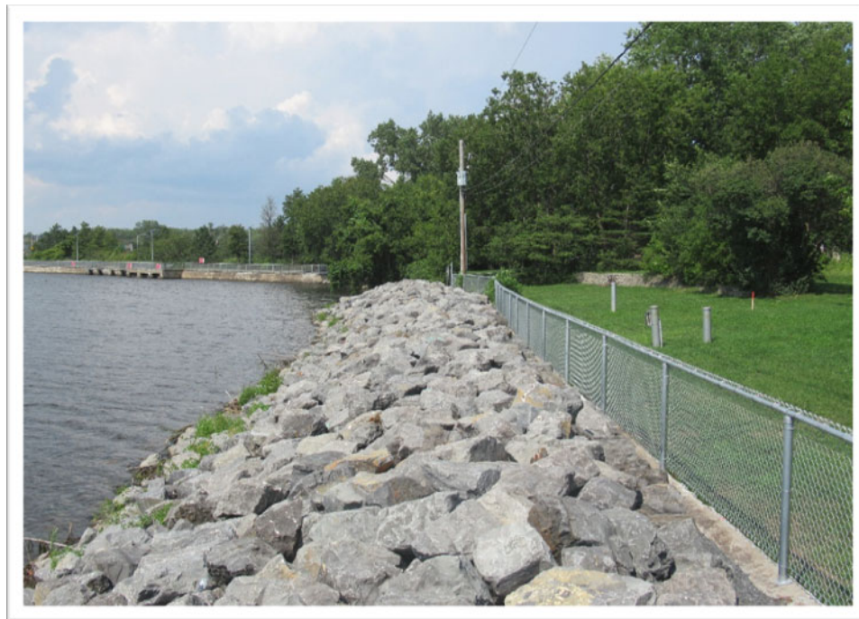
PHOTO 11 — Vue vers l'est du remblai d'enrochement situé le long de la partie nord de la section du mur de soutènement située dans le secteur des Sœurs de la Miséricorde.
