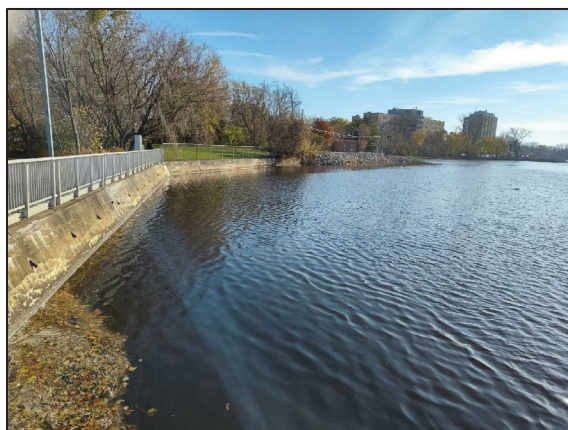
Photographie 5-1 Secteur du barrage poids – vue vers l'amont – 16 novembre 2023
