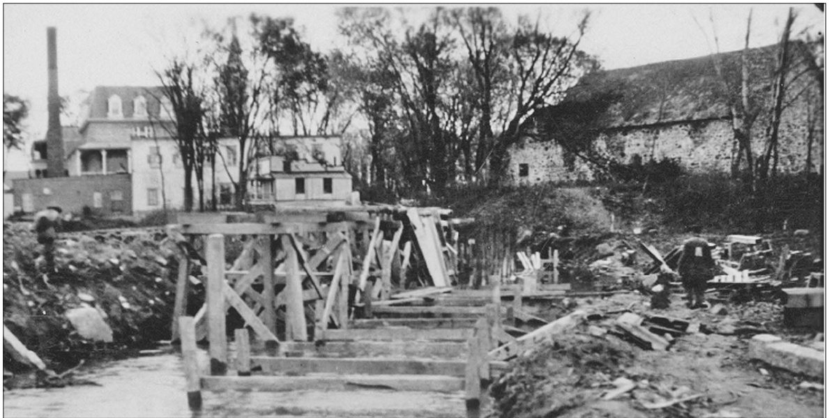
Figure 5.31 Photo des travaux, 1928
