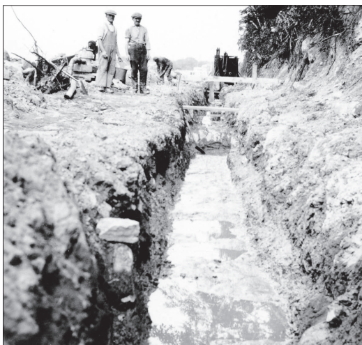
Figure 7.10 Photo d'une tranchée pour l'installation du mur de soutènement
