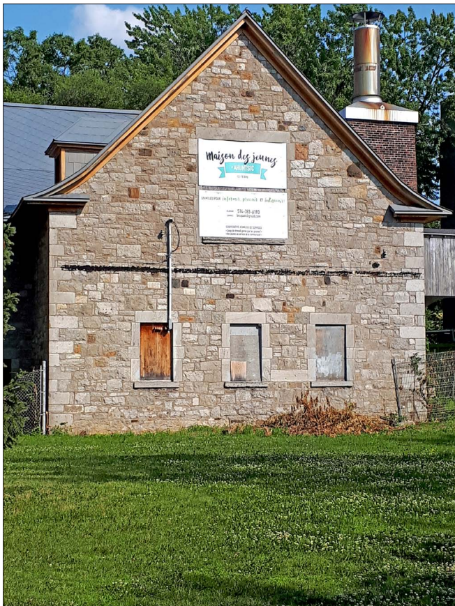
Figure 5.10 La chaufferie maintenant abandonnée Photo Archéotec 2018
