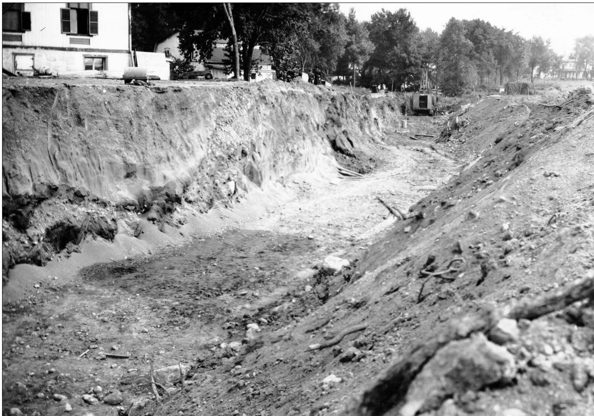
Figure 7.4 Sillon creusé sur la rive pour y installer le mur
