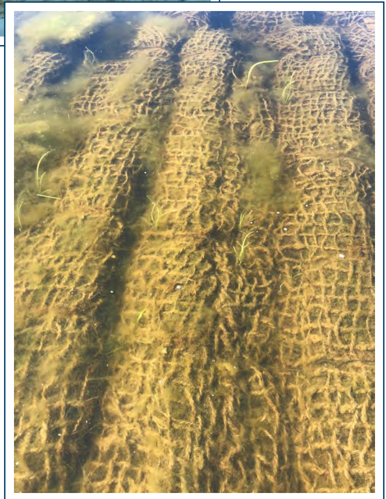
PHOTO 26 — État des boudins - AFFM
