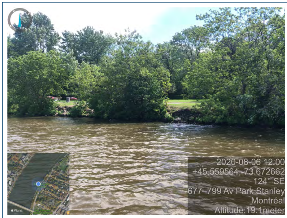
PHOTO 2 — Érosion de la berge au niveau du tronçon 3
