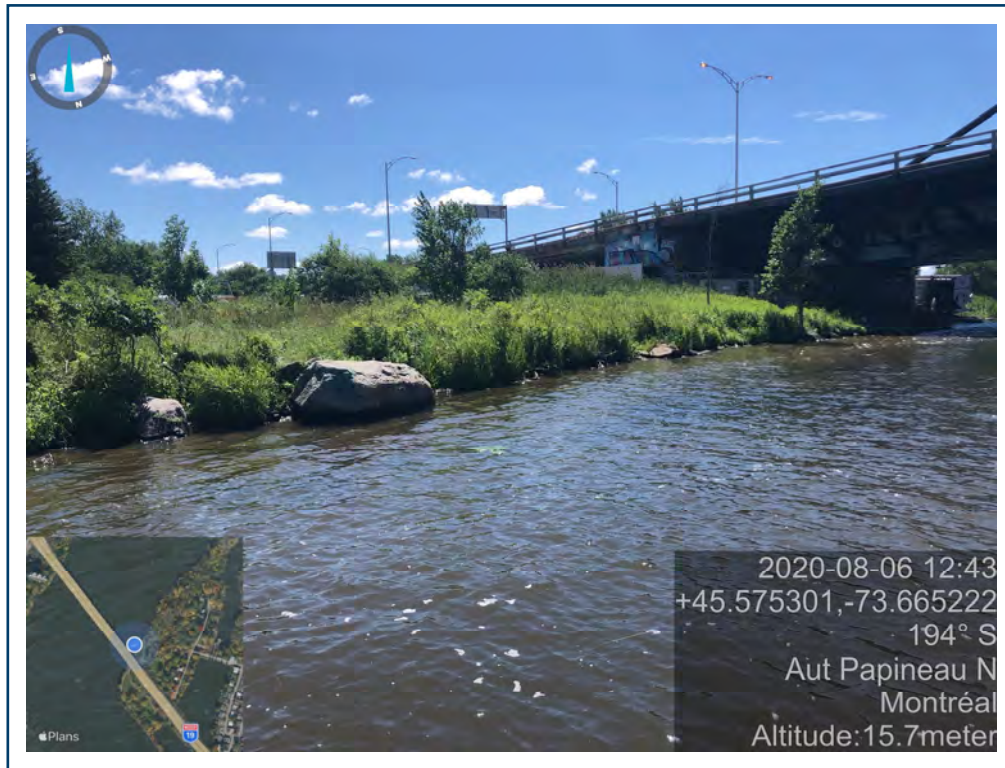
PHOTO 1 — Pente de la berge faible au niveau du tronçon 16
