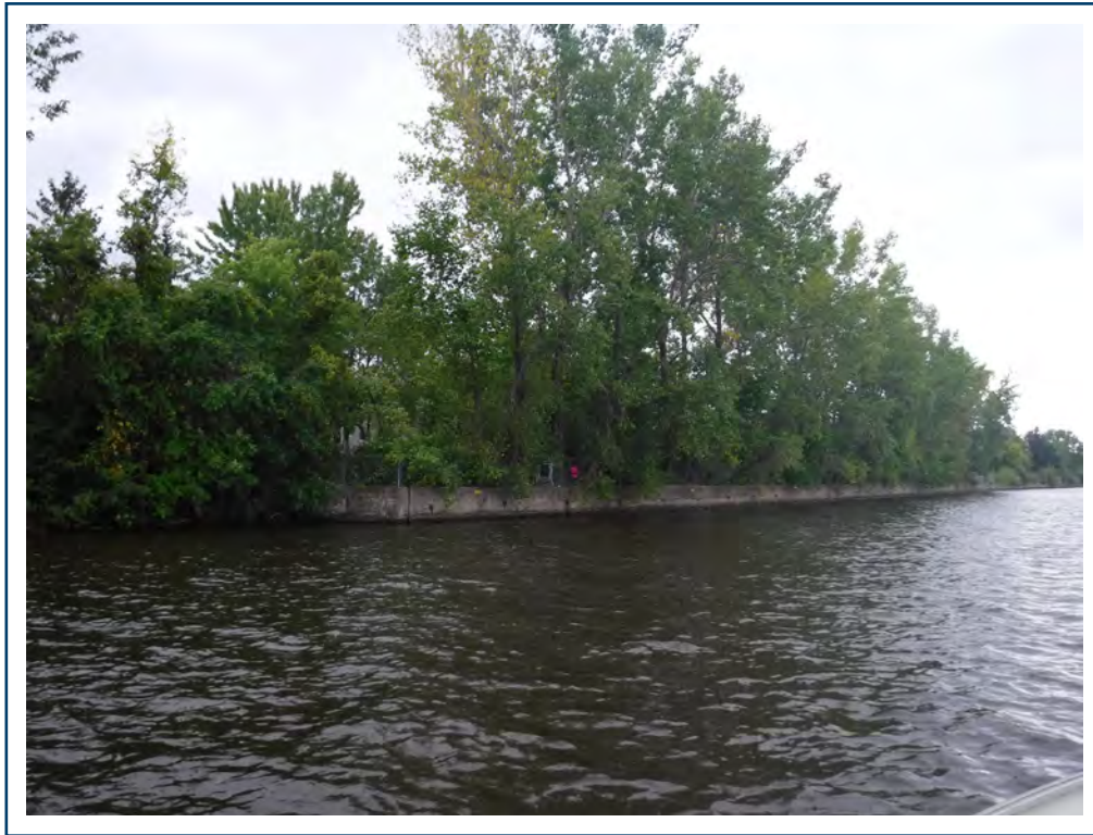
PHOTO 9 — Mur de soutènement ne présentant pas de potentiel de lézardage pour les tortues
