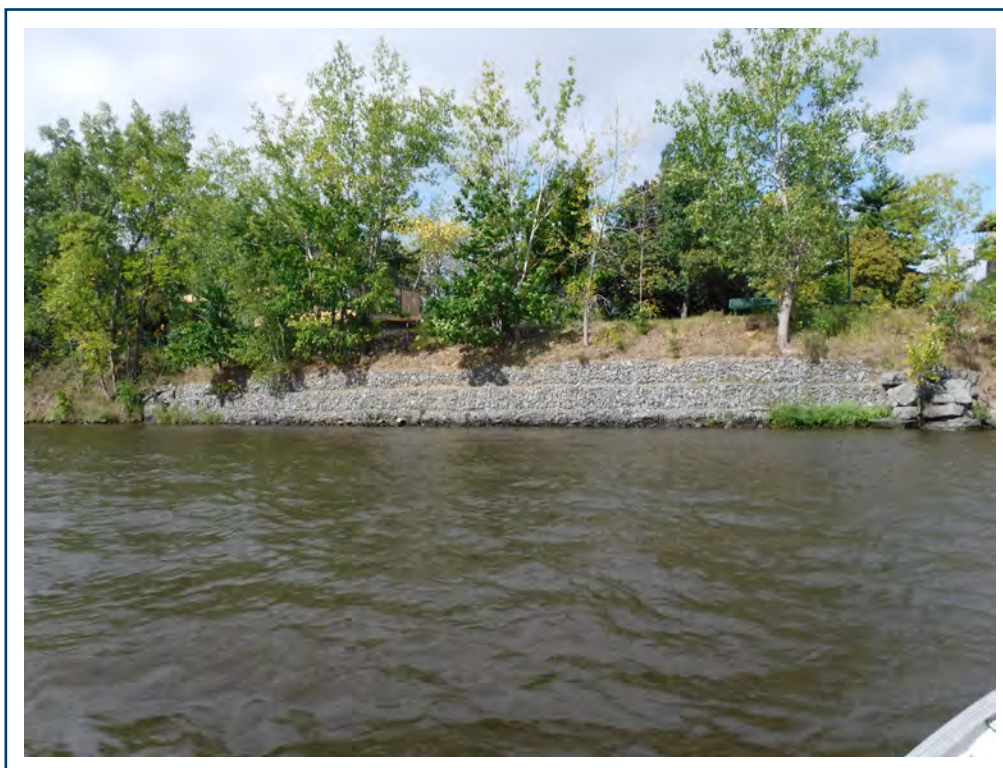
PHOTO 4 — Enrochement ne présentant pas de potentiel de lézardage pour les tortues
