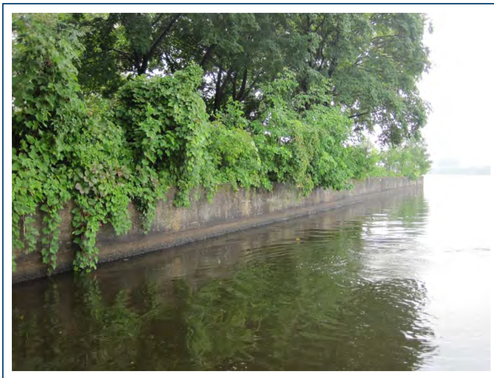
PHOTO 12 — Tronçon 7 vers l'amont
