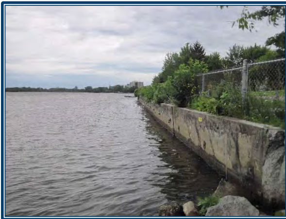
Muret de ciment
