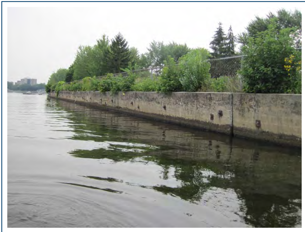
PHOTO 6 — Tronçon 1 vers l'aval
