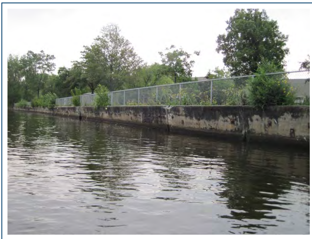
PHOTO 7 — Tronçon 2 vers l'aval
