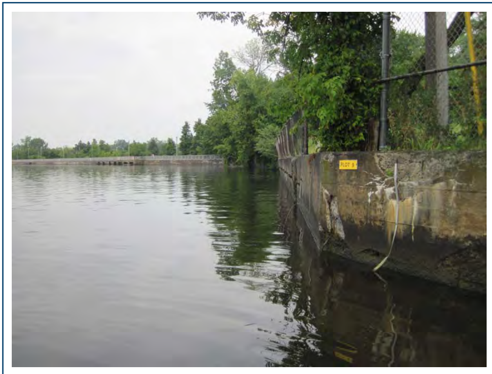
PHOTO 14 — Tronçon 9 vers l'aval
