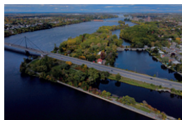
Vue aérienne d'une partie du barrage Simon-Sicard (en bas à droite), du parc nature de l'Île-de-la-Visitation et de la centrale de la Rivière-des-Prairies (au fond)
