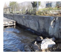
État des murs
