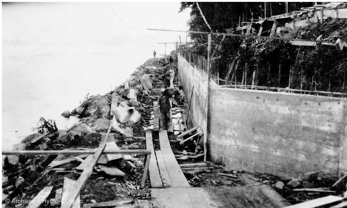
Photo 3-1 : Construction du mur de soutènement en 1928-1929
