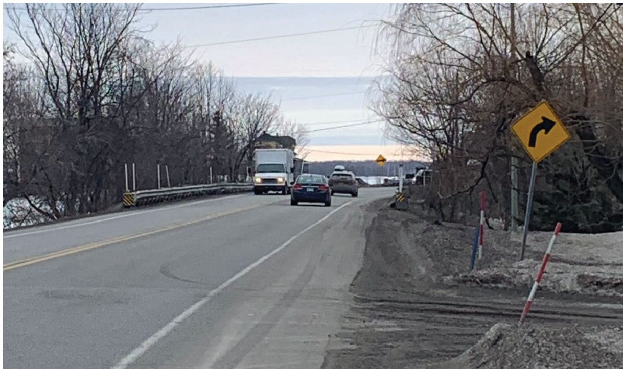
Photo 5-2 : Exemple de visibilité réduite depuis une entrée charretière à proximité d'une courbe sur la R-125
