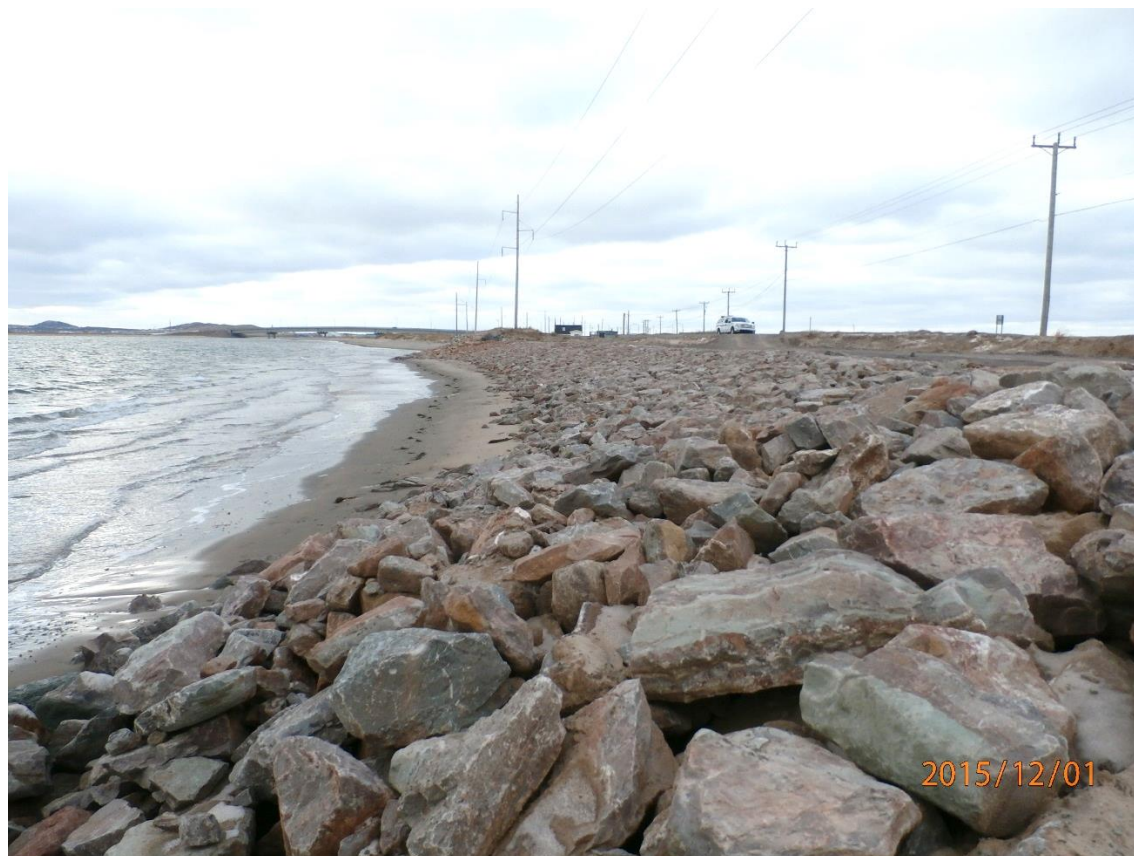
Figure 6-8 : Exemple de rip-rap aménagé au site F0104, dans le secteur des Îles-de-la-Madeleine
