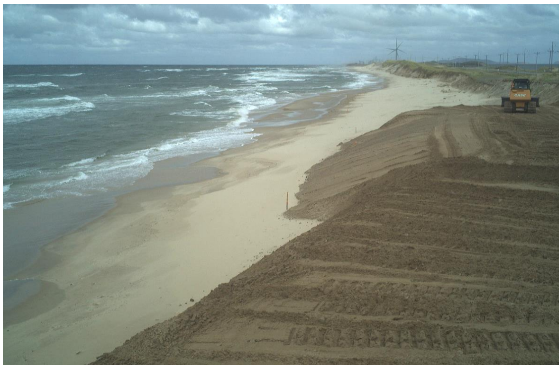
Figure 6-10 : Exemple de recharge sédimentaire en cours d'aménagement au site F0108, dans le secteur des Îles-de-la-Madeleine
