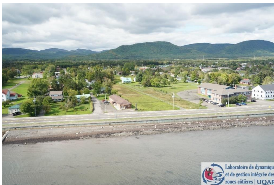
Figure 6-2 : Exemple de mur de protection aménagé au site A1301 à Maria, dans le secteur Gaspésie - Baie-des-Chaleurs
