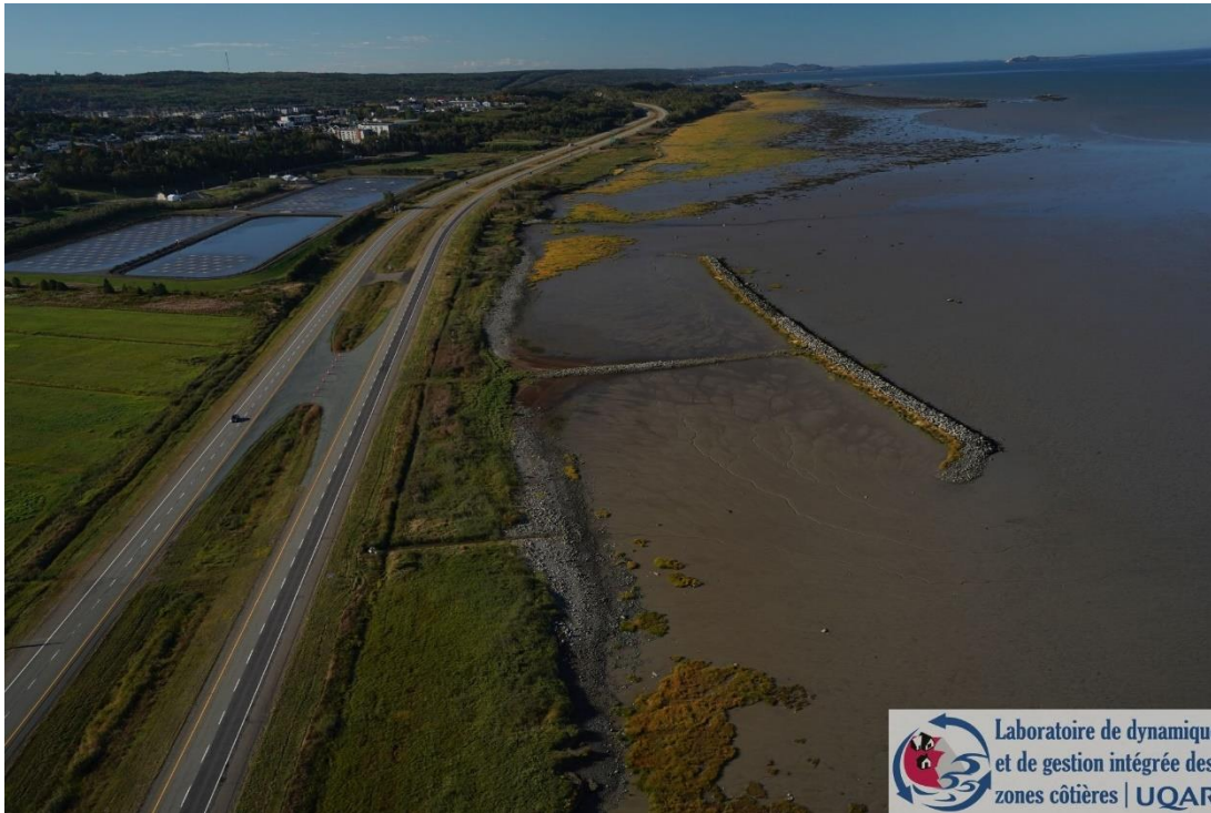
Figure 6-6 : Exemple d'un brise-lames attaché aménagé au site G0201 à Rivière-du-Loup, dans le secteur du Bas-Saint-Laurent
