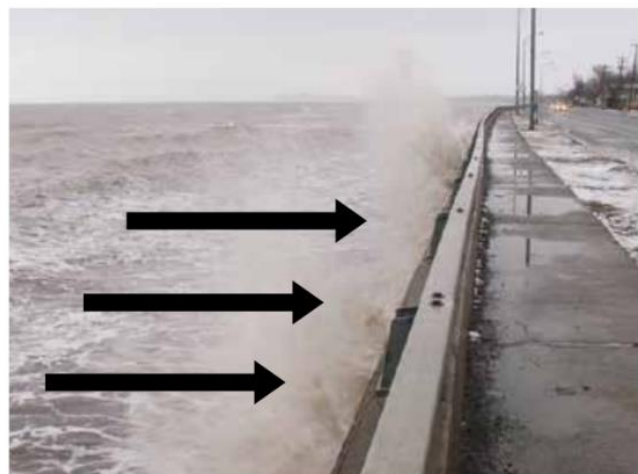
Figure 6-15 : Réflexion des vagues au contact d'une structure verticale
