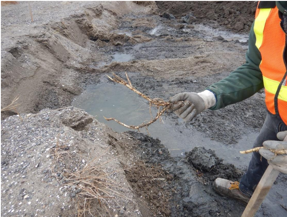
Figure 11-8 : Exemple de pointe de croissance d'un rhizome de roseau commun retirée manuellement à la pelle lors de l'excavation
