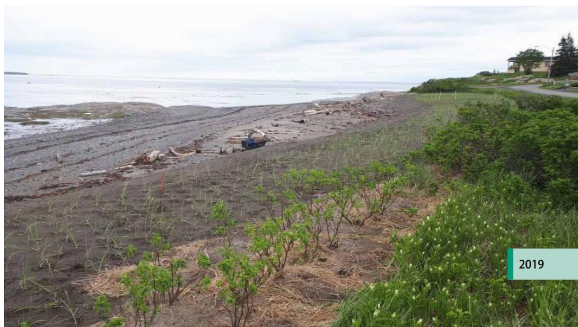
Figure 6-13 : Recharge sédimentaire impliquant le génie végétal à Notre-Dame-des-Neiges
