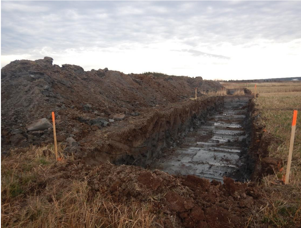
Figure 11-9 : Exemple de fosse destinée à accueillir les sols contaminés par le roseau commun
