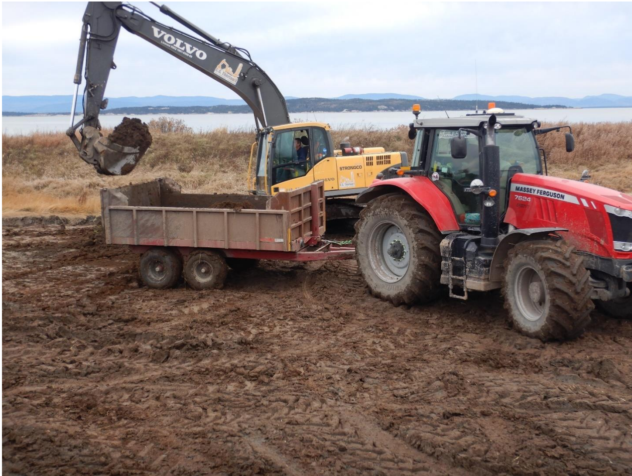
Figure 11-10 : Exemple de transporteur moyen utilisé pour les travaux
