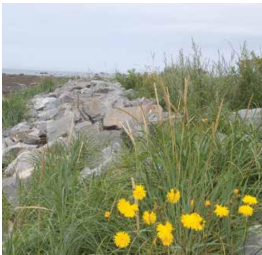
Figure 6-12 : Végétalisation d'enrochement
