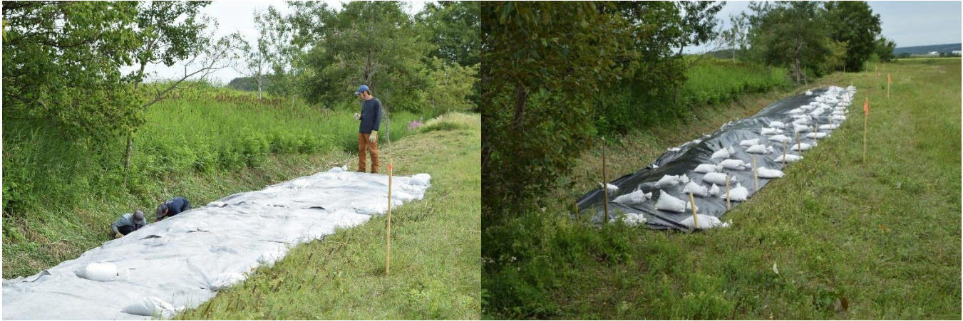
Figure 11-7 : Installation du géotextile (gauche) et de la géomembrane avec pose des sacs de sable (droite)
