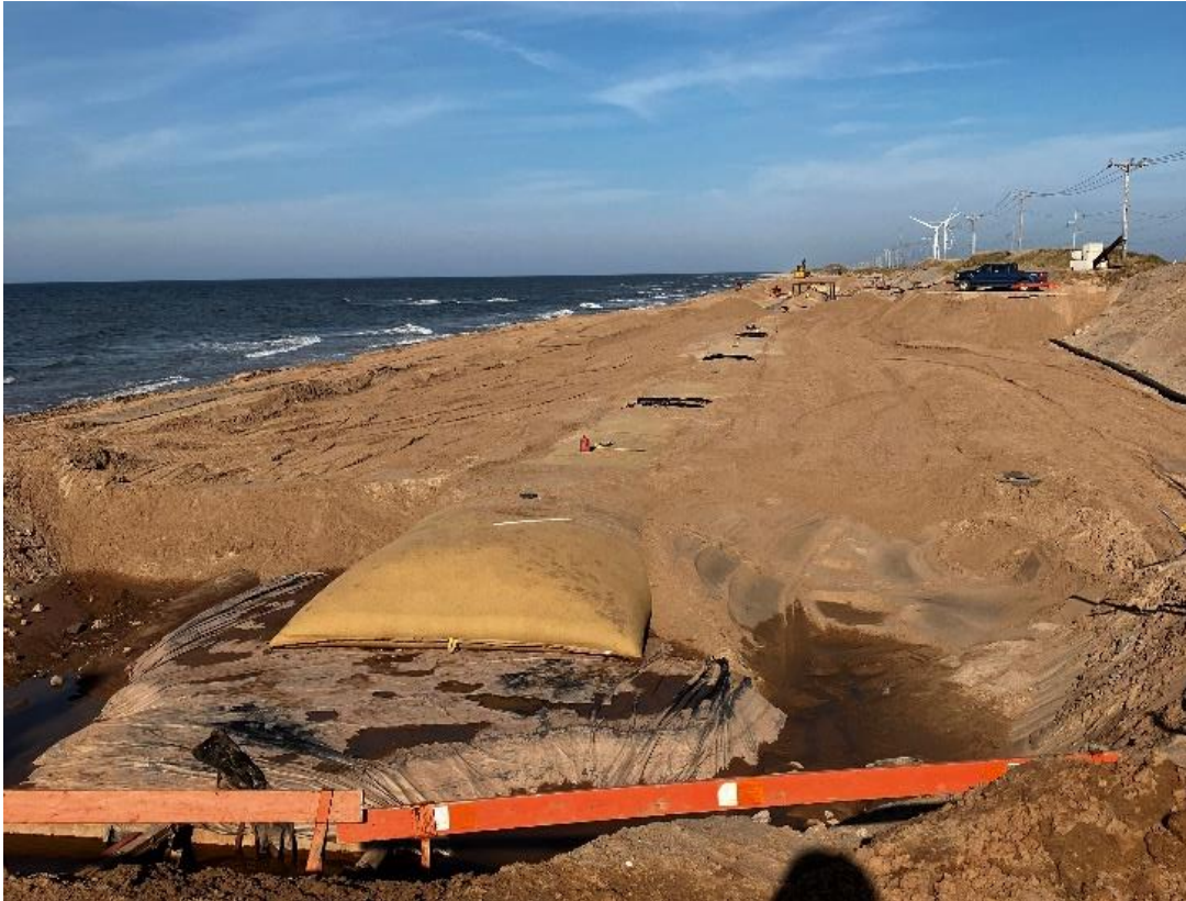
Figure 6-5 : Exemple de conteneurs en géotextile aménagés en combinaison d'une recharge sédimentaire au site F0110, dans le secteur des Îles-de-la-Madeleine
