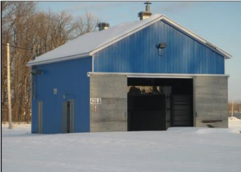
Bâtiment 439, GD-OTS Valleyfield 2025.
