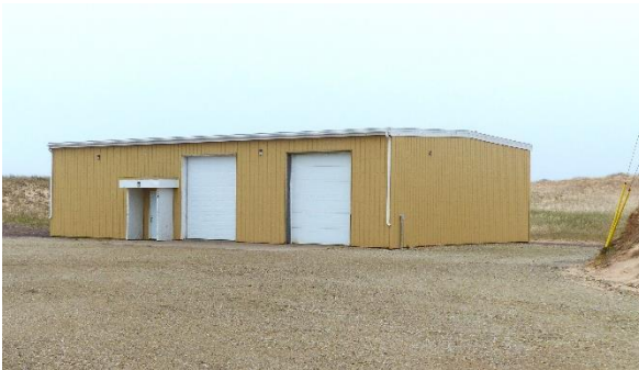
Photo 3. Bâtiment (dépôt d'explosifs) situé sur le bail de location à des fins industrielles (droit n° 113298)
