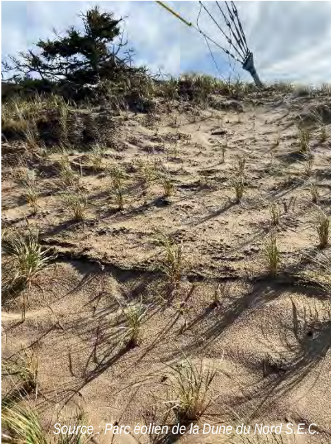
Figure 7. Tapis de coco ensemençés d'ammophile à ligule courte lors de la stabilisation du milieu dunaire
