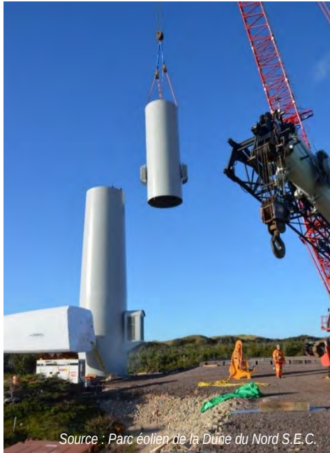
Figure 5. Assemblage d'une tour d'éolienne par section
