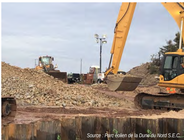
Figure 3. Machinerie lourde circulant sur le chantier
