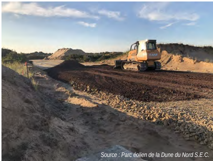
Figure 2. Amélioration d'un chemin en milieu dunaire
