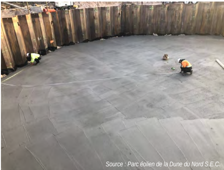
Figure 4. Construction d'une fondation circulaire d'éolienne
