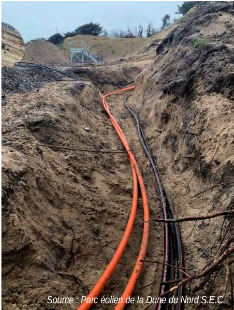
Figure 6. Installation d'un réseau collecteur souterrain
