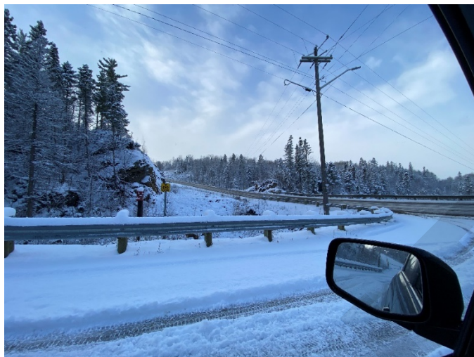
Figure 2-6 Vue de l'approche sud depuis l'accès sud pour un véhicule arrêté à la ligne d'arrêt
