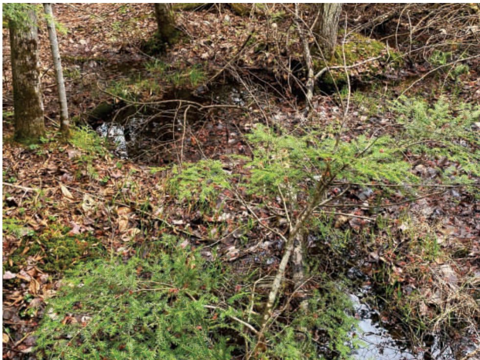
PHOTO 34 Obstacle souterrain infranchissable du cours d'eau CE-165, mai 2025
