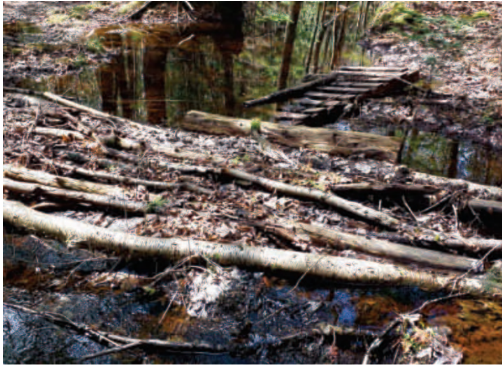
PHOTO 17 Obstacle embâcle anthropique du cours d'eau CE-024, segment S02, mai 2025
