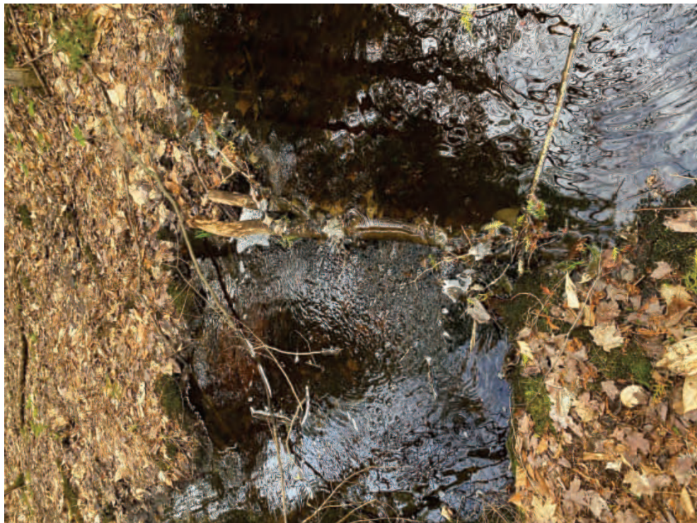
PHOTO 18 Obstacle embâcle du cours d'eau CE-024, segment S02, mai 2025
