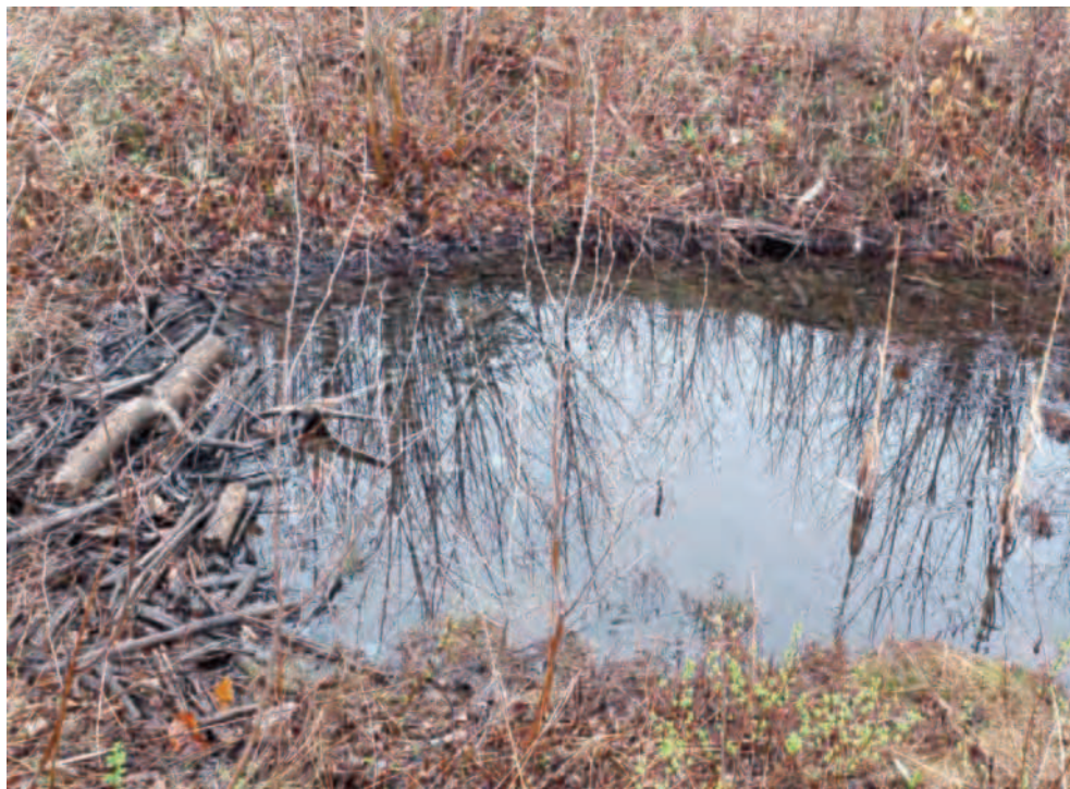
PHOTO 11 Bassin à la suite d'une embâcle à la fin du cours d'eau CE-177, mai 2025
