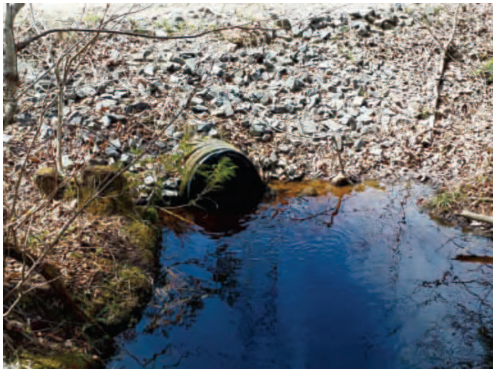
PHOTO 20 Ponceau du cours d'eau CE-024, segment S04, mai 2025
