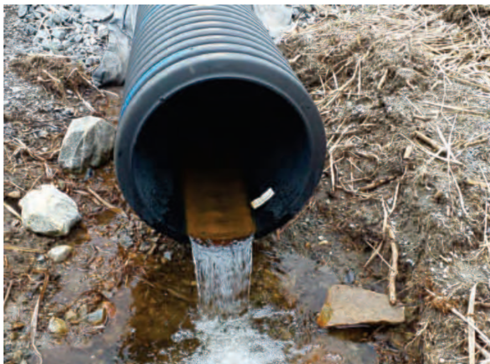
PHOTO 14 Ponceau du cours d'eau CE-079, mai 2025
