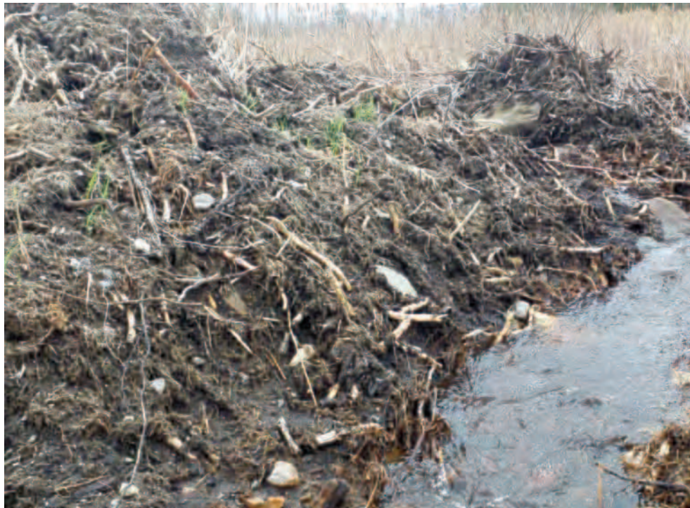
PHOTO 15 Talus impacté par pelle mécanique du cours d'eau CE-079, mai 2025
