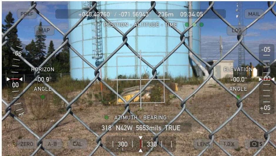
Figure 7 : Réservoir d'eau potable
