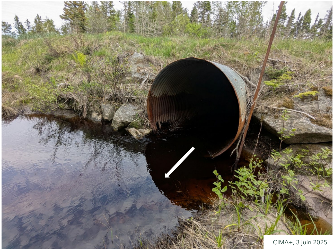
Photo 2.11 : Vue présentant l'aval du ponceau existant (TTOG Ø 1 500 mm) sous la route 138 rencontré par le ruisseau des Platains
