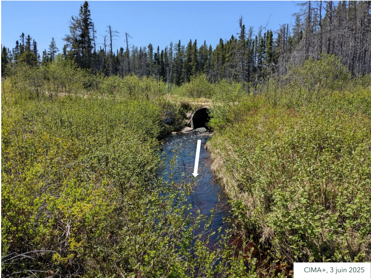
Photo 2.8 : Vue présentant l'aval du ponceau existant (TTOG Ø 1500 mm) sous le premier chemin de VTT rencontré par le ruisseau des Platains
