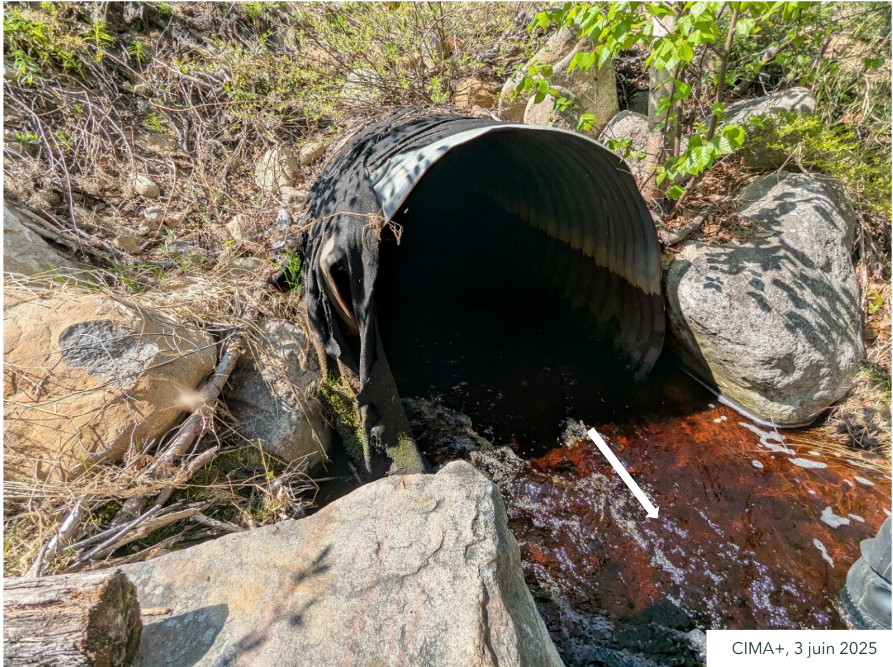
Photo 2.10 : Vue présentant l'aval du ponceau existant (TTOG Ø 1 500 mm) sous le deuxième chemin de VTT rencontré par le ruisseau des Platains
