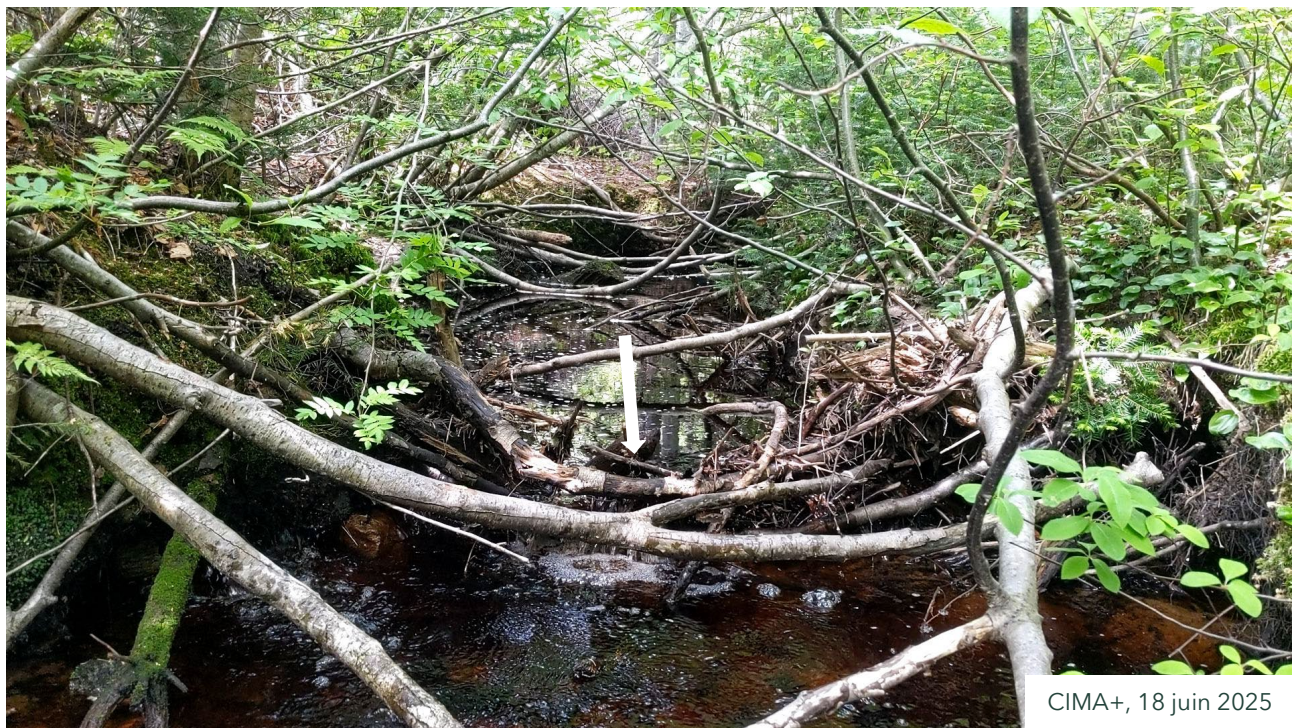
Photo 2.5 : Seuil causé par un obstruction dans le ruisseau des Platans (à l'aval du deuxième chemin en VTT)
