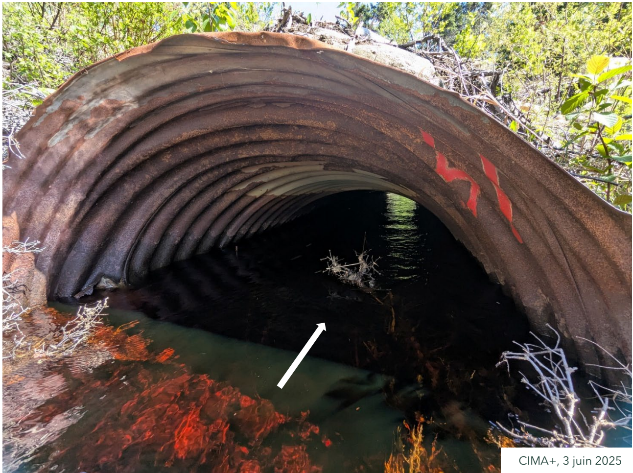
Photo 2.9 : Vue présentant l'amont du ponceau existant (TTOG Ø 1 500 mm) sous le deuxième chemin de VTT rencontré par le ruisseau des Platains
