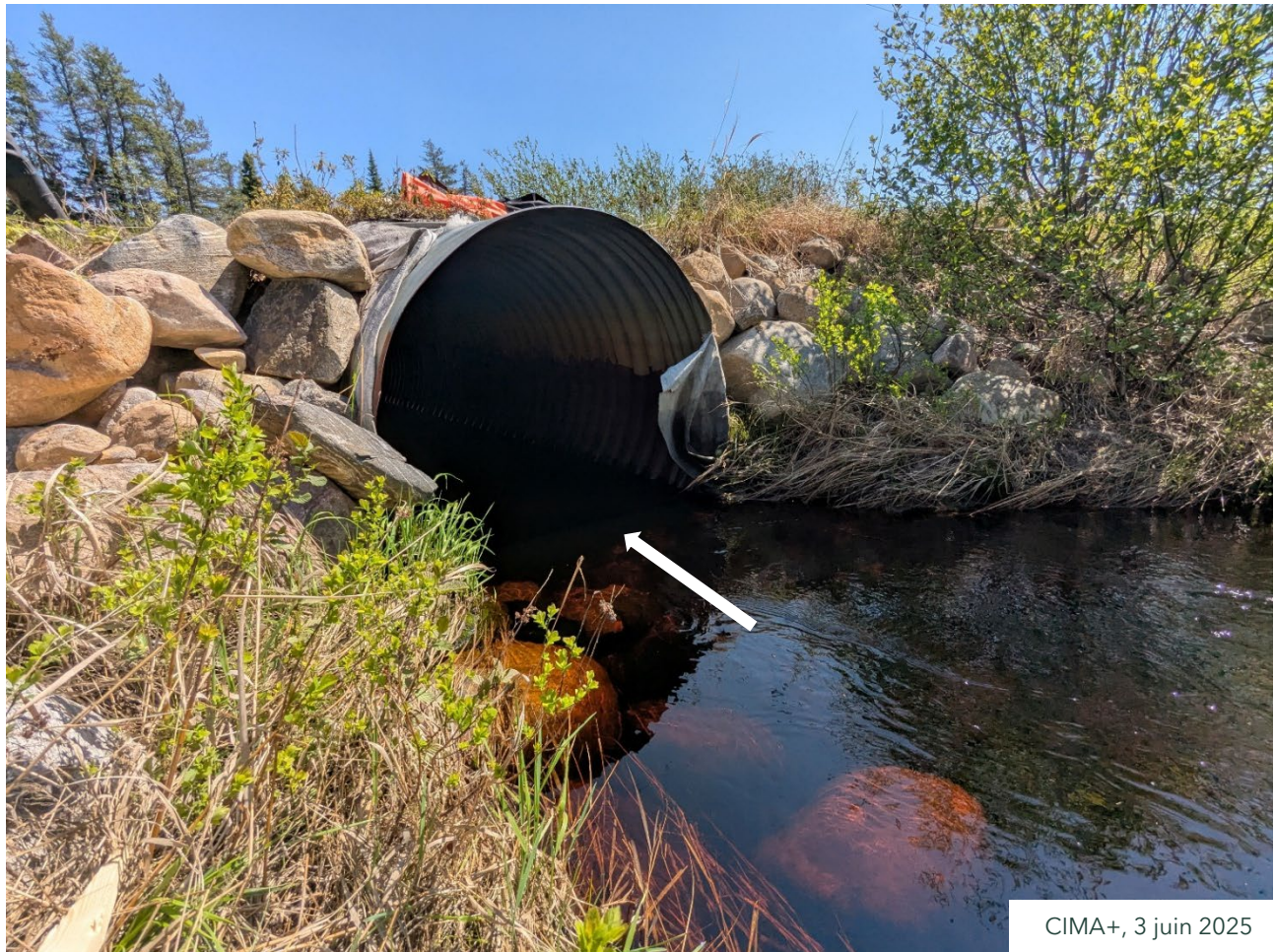
Photo 2.7 : Vue présentant l'amont du ponceau existant (TTOG Ø 1 500 mm) sous le premier chemin de VTT rencontré par le ruisseau des Platains
