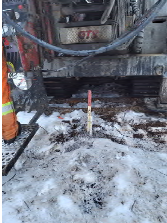
Photographie 3 : Forage TF-09-23
