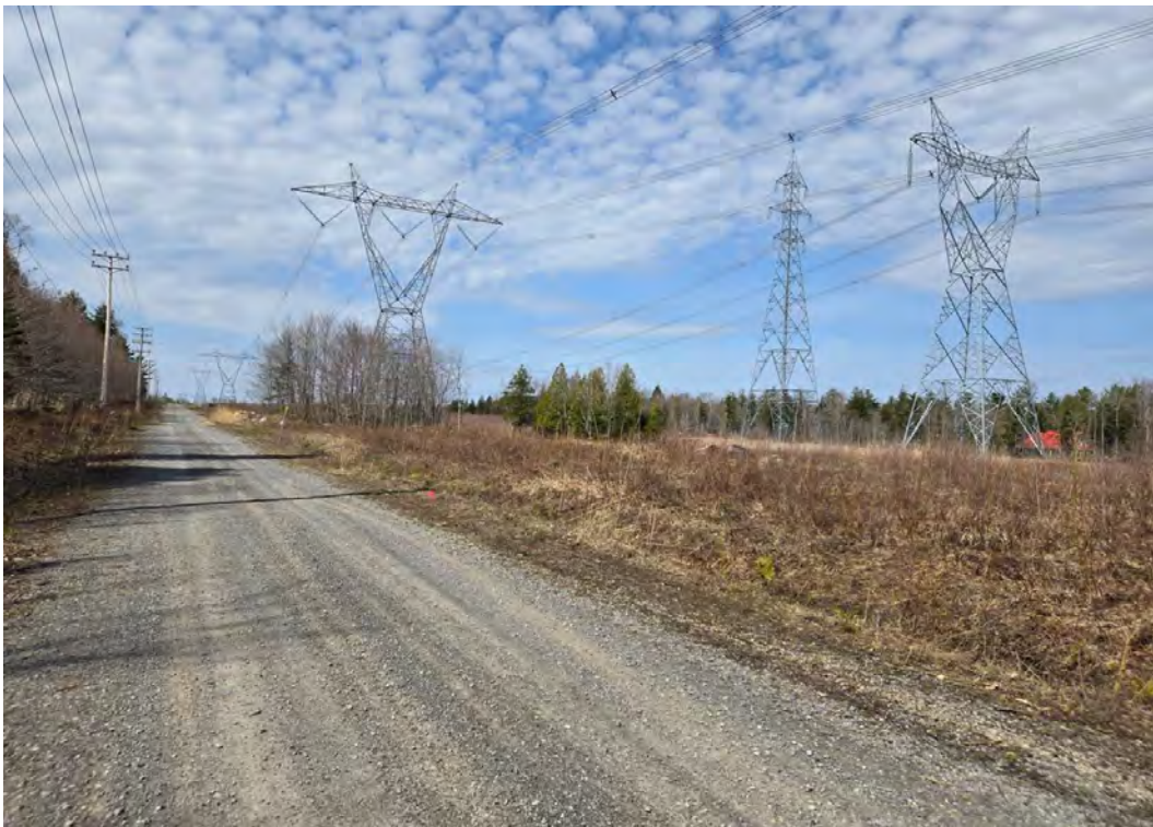
Photo n°2. Poteaux et pylônes électriques dans l'emprise des lignes
