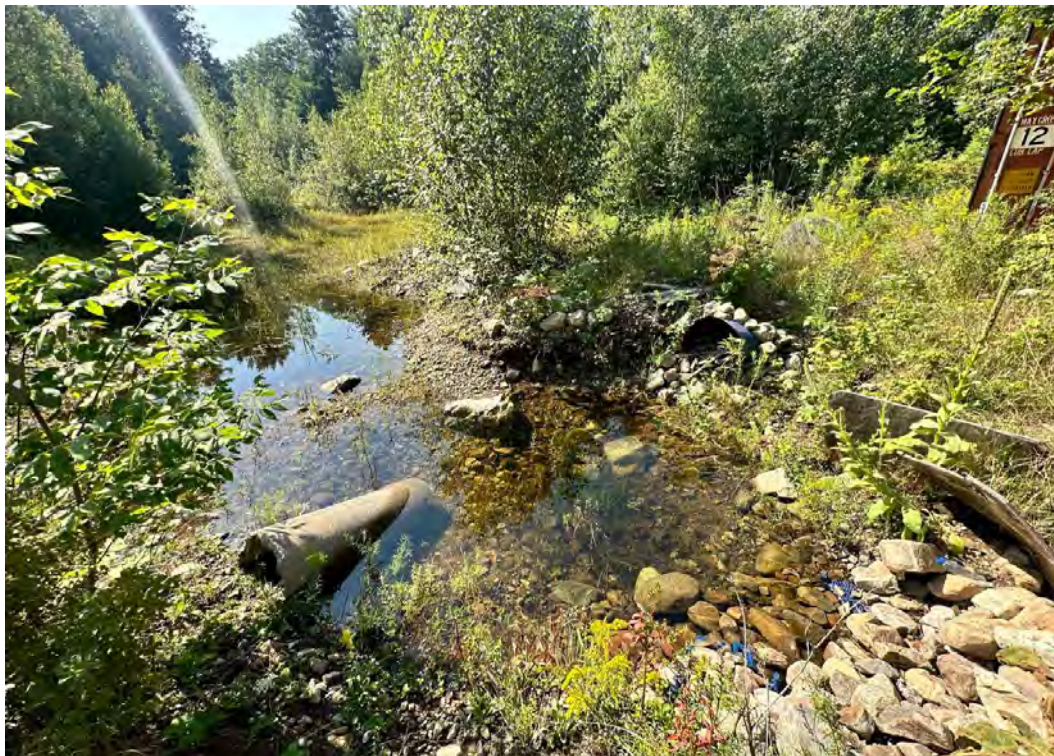
Photographie n°18. Remblaiement possible effectué dans le milieu sensible
