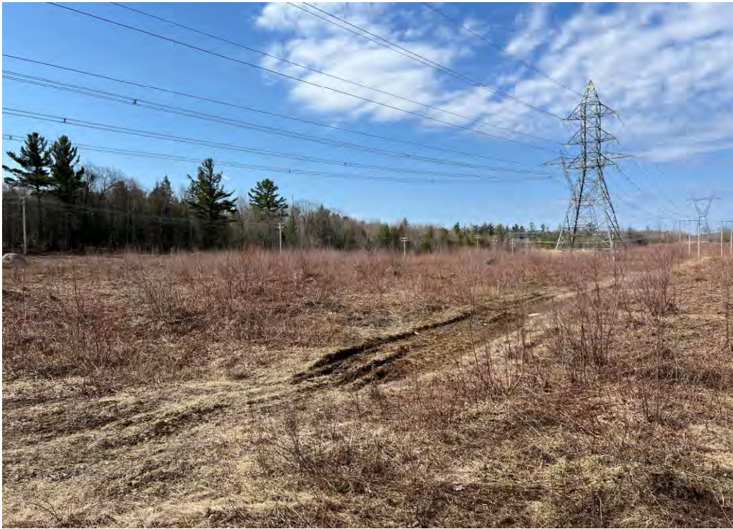
Photo n°1. Pylônes électriques et poteaux en bois traité sur le Terrain
