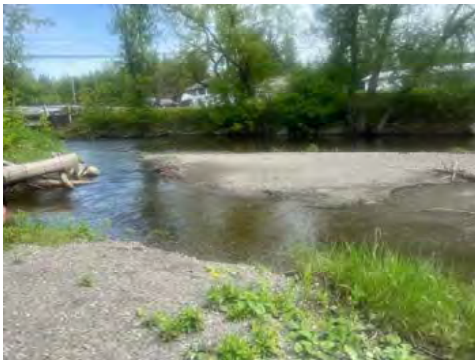
Banc de sédimentation problématique près du pont de la rue Demers (47.41880, -68.39196)
