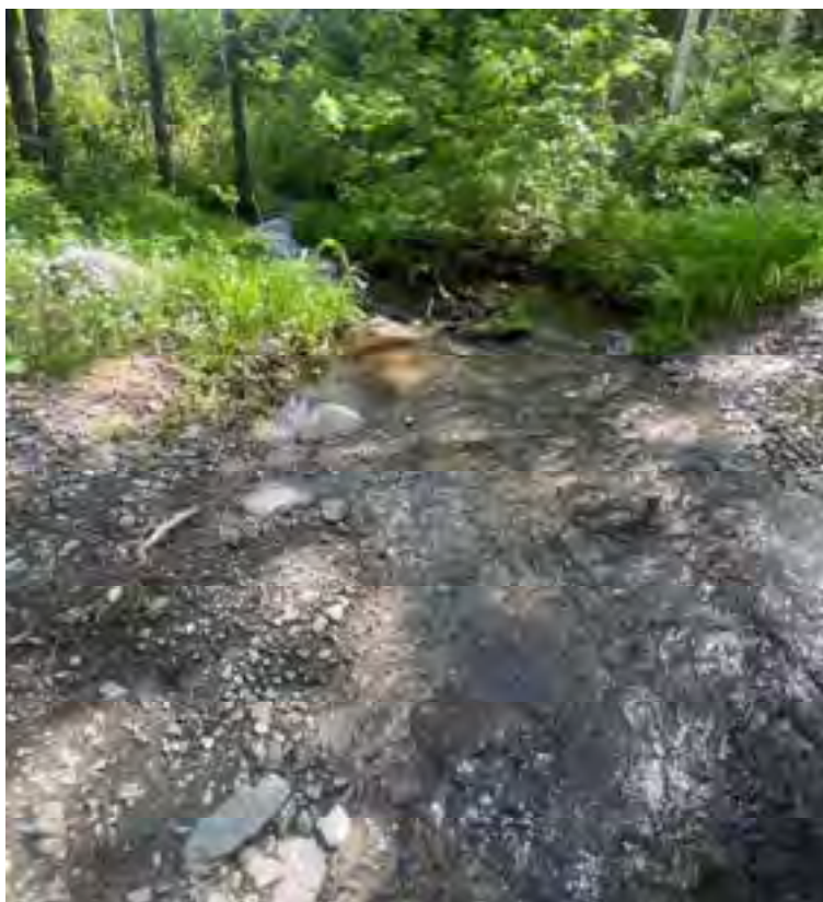
Passage à gué sur un chemin (47.46521, -68.51857)
