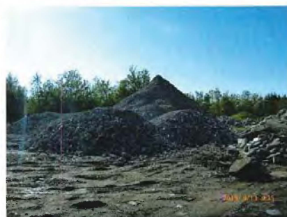
P1040791.JPG Photo 4. Amas de béton concassé (< 30 cm³)
