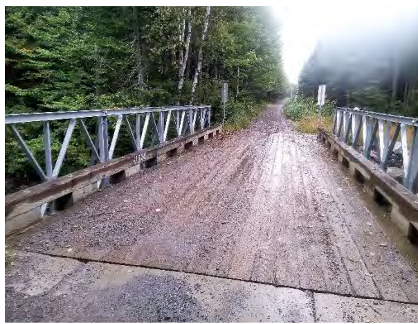
Photo 24. Pont à la station SEC04 (2022)
