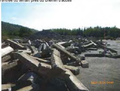
P1060019.JPG Photo 3. Amas de morceaux de dalle de béton situé dans la sablière
