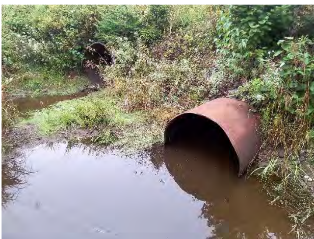
Photo 23. Ponceau à la station SEC06 (2022)
