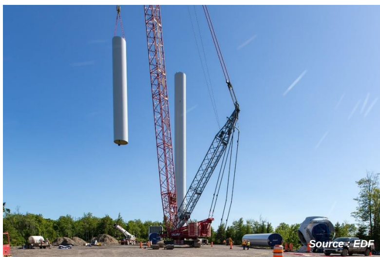
Figure 6. Assemblage d'une tour d'éolienne
