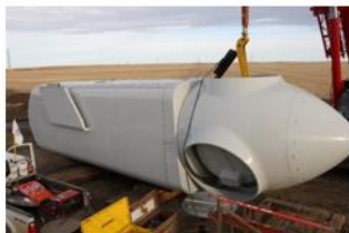
Installation de la nacelle
