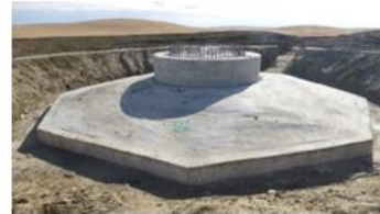
L'excavation des fondations est d'un diamètre d'environ 25 mètres. Une quantité d'environ 800 à 1300 mètres cube de béton est nécessaire pour la fondation de chaque éolienne.
