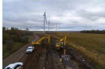
Enfouissement du réseau collecteur.
