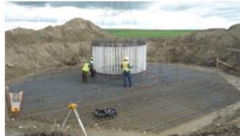
La pose de l'acier d'armature comprend entre 50 et 70 tonnes de barres d'armature.
