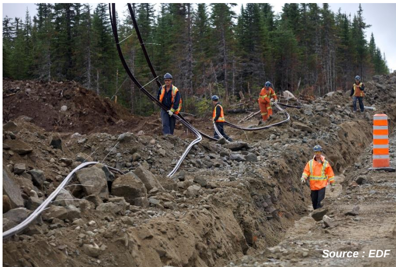
Figure 7. Installation d'un réseau collecteur souterrain
