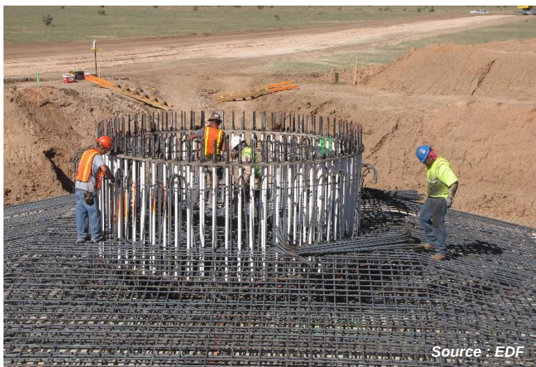
Figure 5. Construction d'une fondation d'éolienne de type gravitaire
