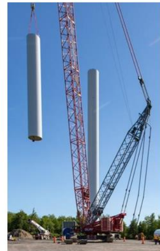
Assemblage de la tour de l'éolienne.
