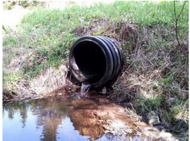
Photo 14. CE02, ponceau simple en plastique (SH001)
