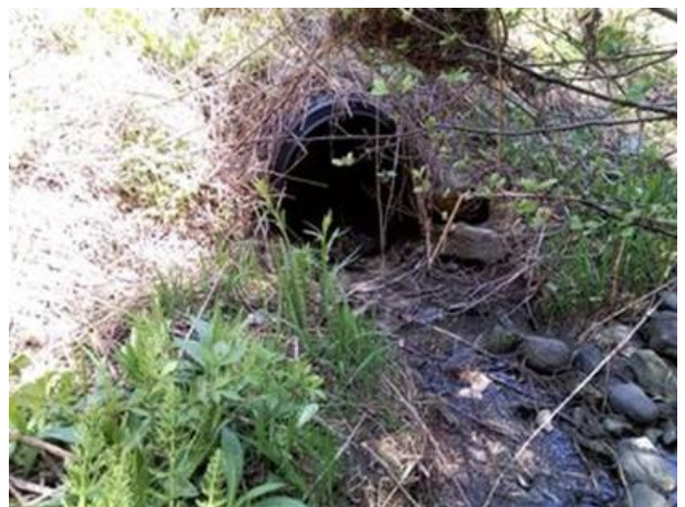
Photo 18. CE06, ponceau simple en plastique (SH041)
