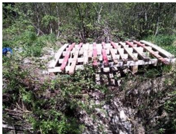
Photo 8. CE4, chaussée de l'infrastructure existante (SH002)
