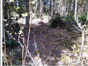
Talus, rive droite
