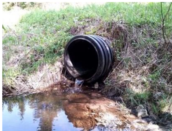
Photo 6. Ponceau simple en plastique, CE2 (SH001)
