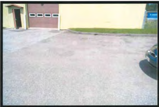
PHOTOGRAPHIE # 6: Partie avant du bâtiment, côté sud-est. Emplacement probable d'anciens réservoirs souterrains et de pompes. Vue vers le nord-ouest.
