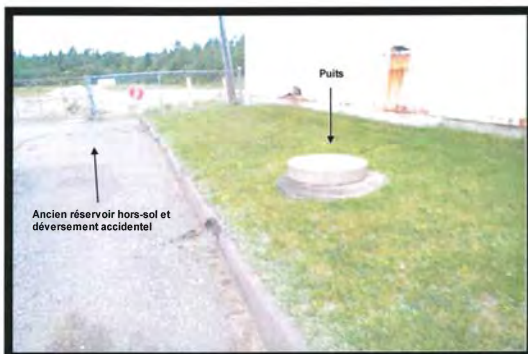
PHOTOGRAPHIE # 10: Espace à l'ouest de l'ancien entrepôt de sel. Emplacement probable de déversement accidentel de produits pétroliers.
