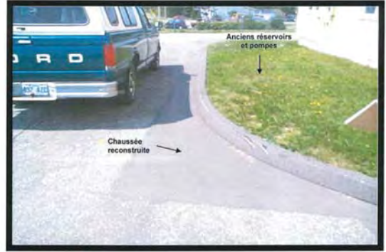
PHOTOGRAPHIE # 7: Partie avant du bâtiment, côté sud-est. Chaussée reconstruite, tranchée probable. Vue vers le sud-ouest.
