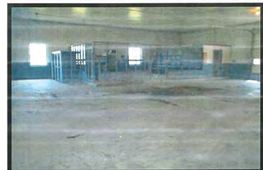
PHOTOGRAPHIE # 25: Intérieur de l'ancien garage. En arrière plan, espace grillagé au coin est du bâtiment.
