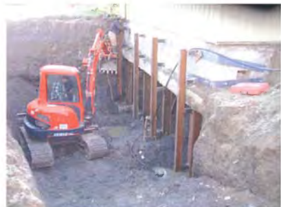
Photo 8 : 16-10-2007 Installation du soutènement et excavation des sols contaminés dans le secteur de l'ancien réservoir d'huile à chauffage. Vue vers le sud.
