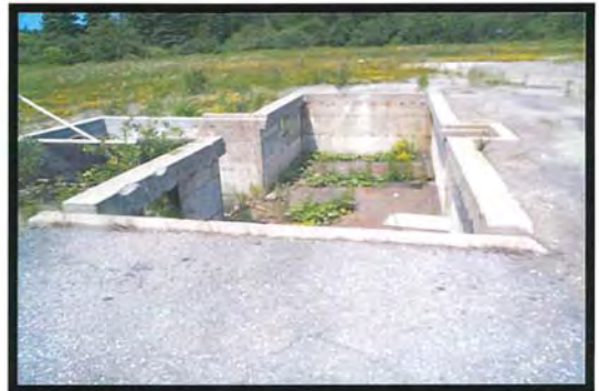
PHOTOGRAPHIE # 16: Fondation d'une ancienne balance pour camions.
