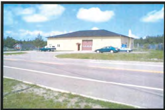
PHOTOGRAPHIE # 1: Aperçu général de la façade sud-est du bâtiment présent sur le site. Vue vers l'ouest. En avant-plan, la Route 216.
