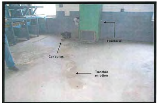
PHOTOGRAPHIE # 28: Intérieur de l'espace grillagé. Fournaise et conduites souterraines.
