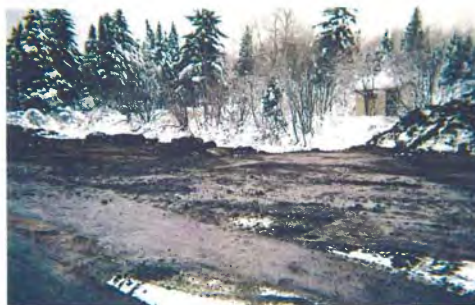
Photo 28 : 21-11-2007 Excavations EX-5 et EX-6 finales. Vue vers l'ouest.
