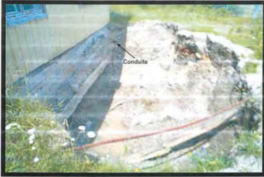
PHOTOGRAPHIE # 11: Tranchée d'un ancien réservoir souterrain d'huile à chauffage enlevé. Nord-est du bâtiment. Vue vers le nord-ouest.
