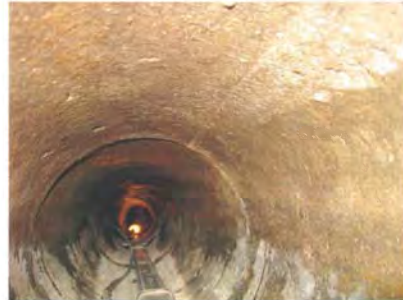
Photo 20 : 31-10-2007 Drain de plancher une fois nettoyé. Vue vers le sud-ouest.
