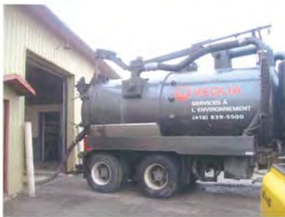
Photo 5 : 11-10-2007 Camion-vacuum utilisé pour le nettoyage de la dalle de béton et des puits de captation. Vue vers le nord.
