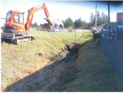
Photo 10 : 16-10-2007 Excavation des sols contaminés dans le secteur de la tranchée PU-5. Vue vers le sud-est.
