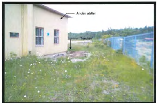
PHOTOGRAPHIE # 4: Aperçu de la façade nord-est du bâtiment en place sur le site. Vue vers le nord-ouest.
