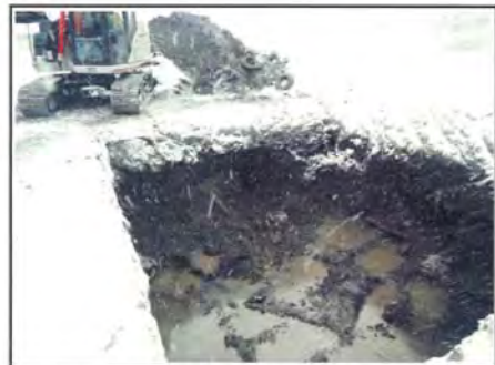
PHOTO 2 : Vue dans l'excavation EX-1 à la fin des travaux d'excavation.
