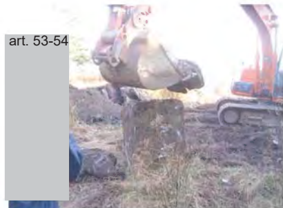
Photo 16 : 29-10-2007 Excavation des sols contaminés et des débris dans le secteur de PU-3. Vue vers le sud.
