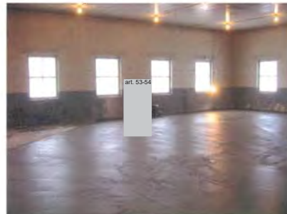
Photo 24 : 07-11-2007 Polissage de la dalle. Vue vers le nord.
