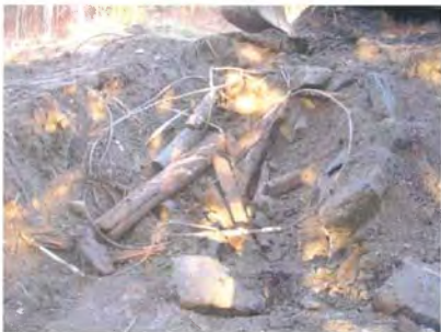
Photo 21 : 31-10-2007 Débris enfouis rencontrés lors des travaux d'excavation dans le secteur nord-ouest du site. Vue vers le nord.
