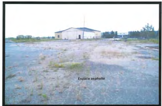
PHOTOGRAPHIE # 3: Aperçu général de la façade nord du bâtiment présent sur le site. Vue vers l'est.
