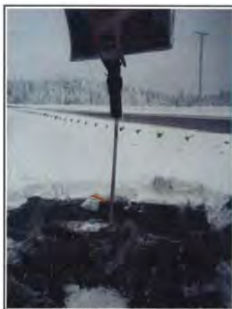
PHOTO 4 : Démantèlement du puits d'observation PO-4.
