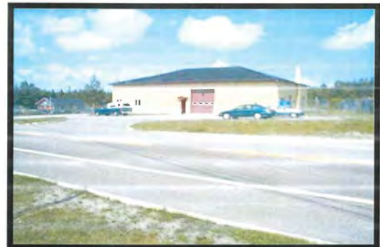
PHOTOGRAPHIE # 1: Aperçu général de la façade sud-est du bâtiment présent sur le site. Vue vers l'ouest. En avant-plan, la Route 216 (rang Taché Est).
