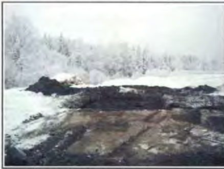
PHOTO 1 : Vue sur l'emplacement de l'excavation EX-1.
