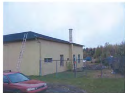
Photo 7 : 15-10-2007 Secteur de l'ancien réservoir souterrain d'huile à chauffage. Vue vers l'ouest.
