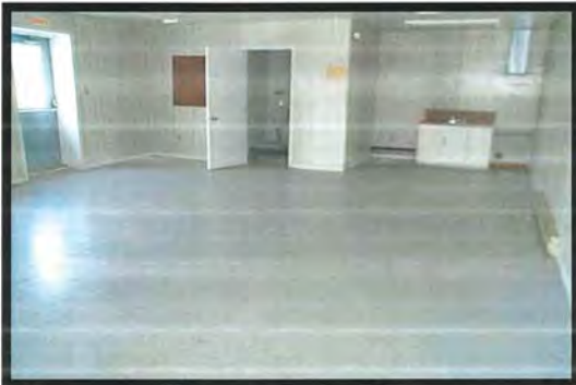
PHOTOGRAPHIE # 20: Partie du bâtiment ayant servi comme espace à bureaux.
