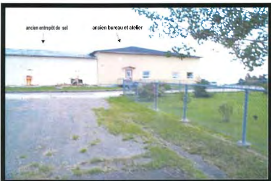
PHOTOGRAPHIE # 2: Aperçu général de la façade sud-ouest du bâtiment présent sur le site. Vue vers l'est.
