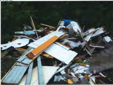
4 - P1020578.JPG Les matières résiduelles sont principalement constituées de résidus de construction, de démolition et de rénovation (CRD).
