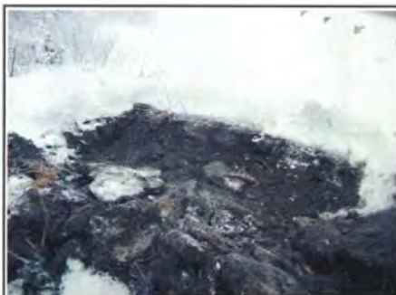
PHOTO 5 : Mise en place de bentonite à l'emplacement du puits d'observation PO-4 Vue du Site à la fin des travaux
