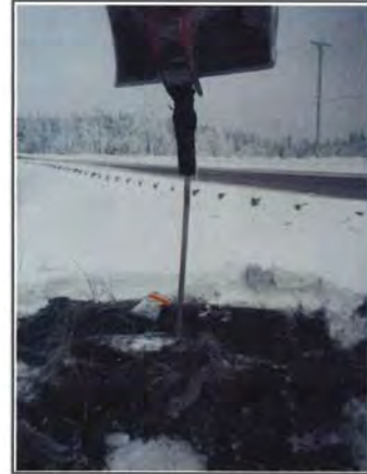
PHOTO 4 : Démantèlement du puits d'observation PO-4.
