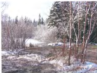
Photo 26 : 08-11-2007 Secteur du sondage PU-3 une fois les sols contaminés et les débris excavés. Vue vers le sud.
