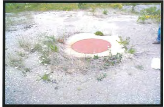
PHOTOGRAPHIE # 15: Fosse septique à l'ouest du bâtiment.
