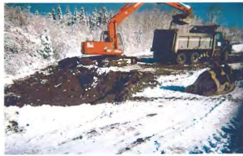
Photo 27 : 19-11-2007 Excavation et chargement des sols « B-C » à l'emplacement de l'excavation EX-5. Vue vers le nord.
