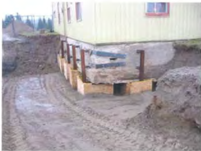
Photo 13 : 25-10-2007 Coffrage installé pour la mise en place du béton sous la fondation. Vue vers le sud.
