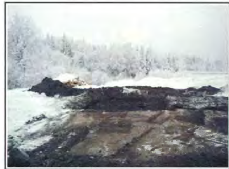
PHOTO 1 : Vue sur l'emplacement de l'excavation EX-1.
