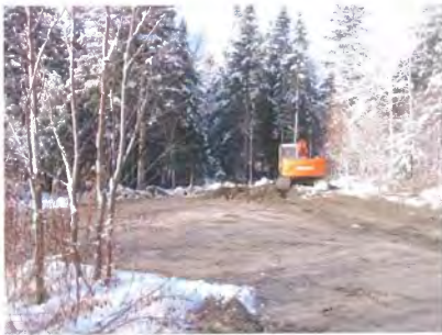
Photo 25 : 08-11-2007 Secteur du sondage PU-3 une fois les sols contaminés et les débris excavés. Vue vers l'ouest.
