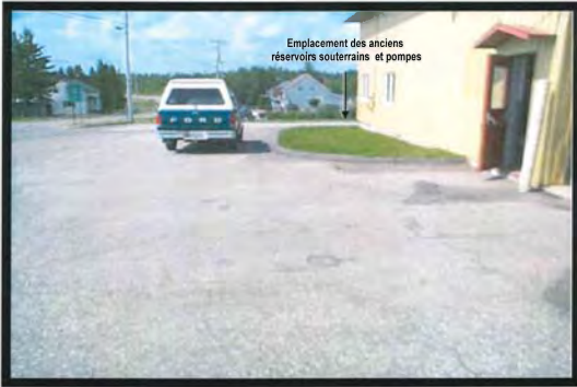
PHOTOGRAPHIE # 5: Espace situé en avant du bâtiment en place, du côté sud-est. Vue vers le sud-ouest.
