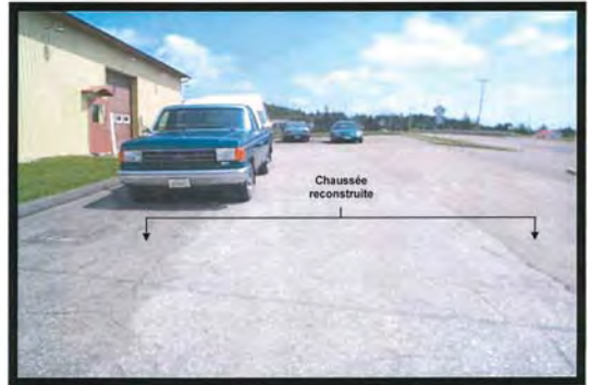
PHOTOGRAPHIE # 8: Partie avant du bâtiment, côté sud-est. Chaussée reconstruite, tranchées probables. Vue vers le nord-est.
