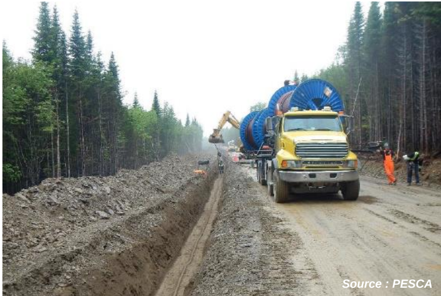
Figure 10. Installation d'un réseau collecteur souterrain
