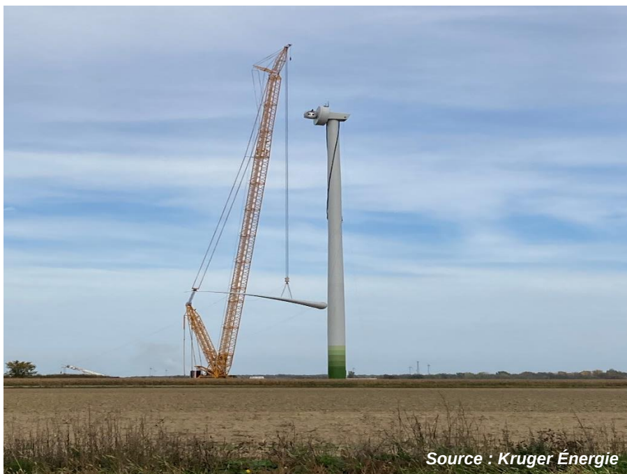
Figure 9. Assemblage d'une pale d'éolienne
