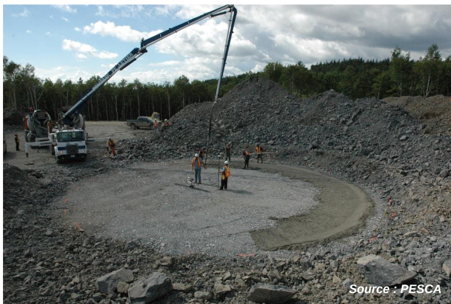
Figure 8. Construction d'une fondation d'éolienne de type gravitaire
