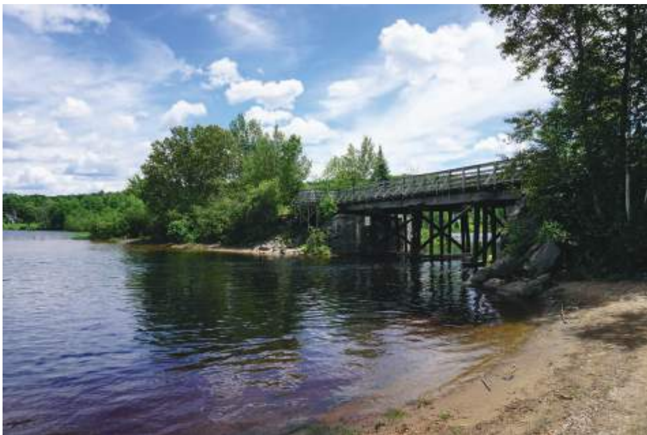
Pont du P'tit Train du Nord au-dessus de la décharge entre le Grand lac et le Petit lac Nominique.
