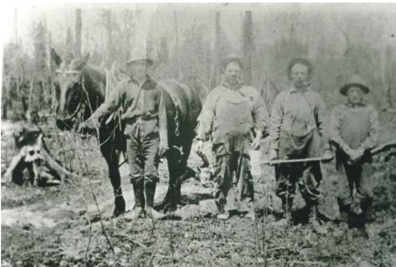
Défrichement sur le lot de Joseph Grenier. Ses aides : Pierre Brunet et ses fils Albert et Arthur Grenier vers 1913.
