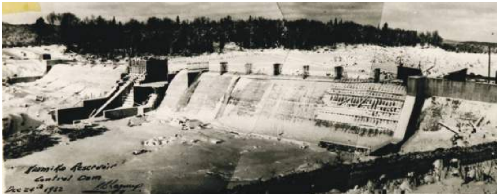
Construction du barrage
