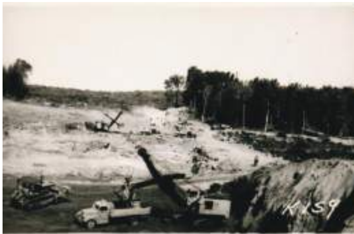
△ Déforestation en vue de la construction du barrage et du réservoir Kiamika.
