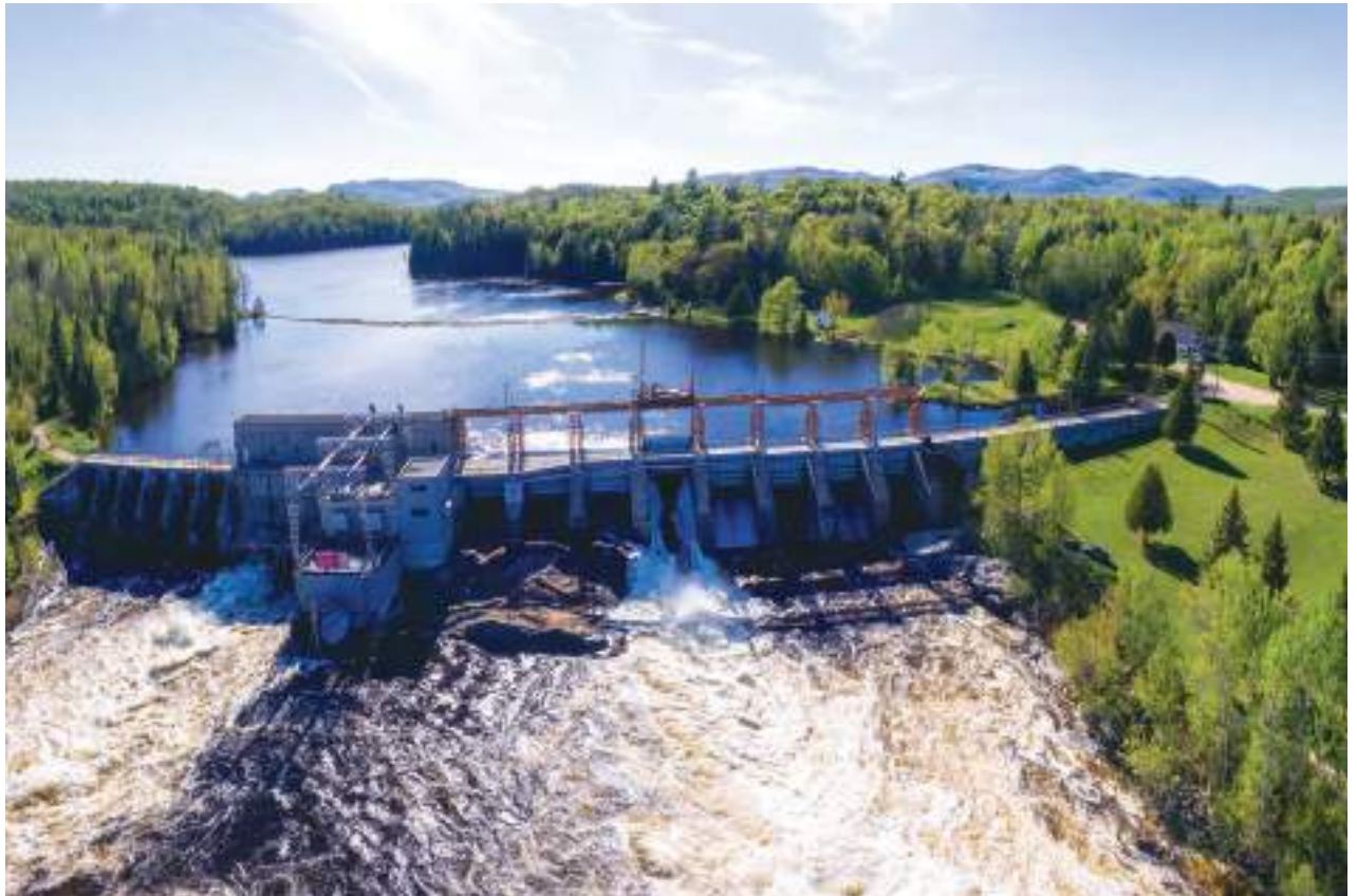
Barrage des Cèdres.
