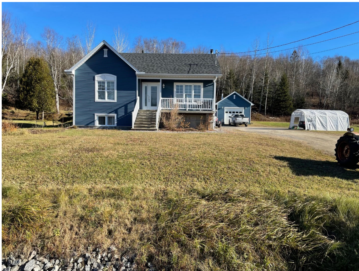
Figure 8: Hauteur du rdc de la résidence 226 Pierre-Neveu par apport au niveau de la route
