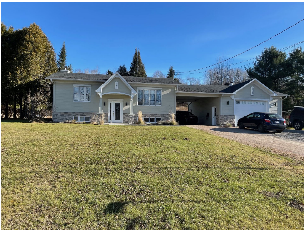
Figure 6: Hauteur du rdc de la résidence 312 Pierre-Neveu par apport au niveau de la route
