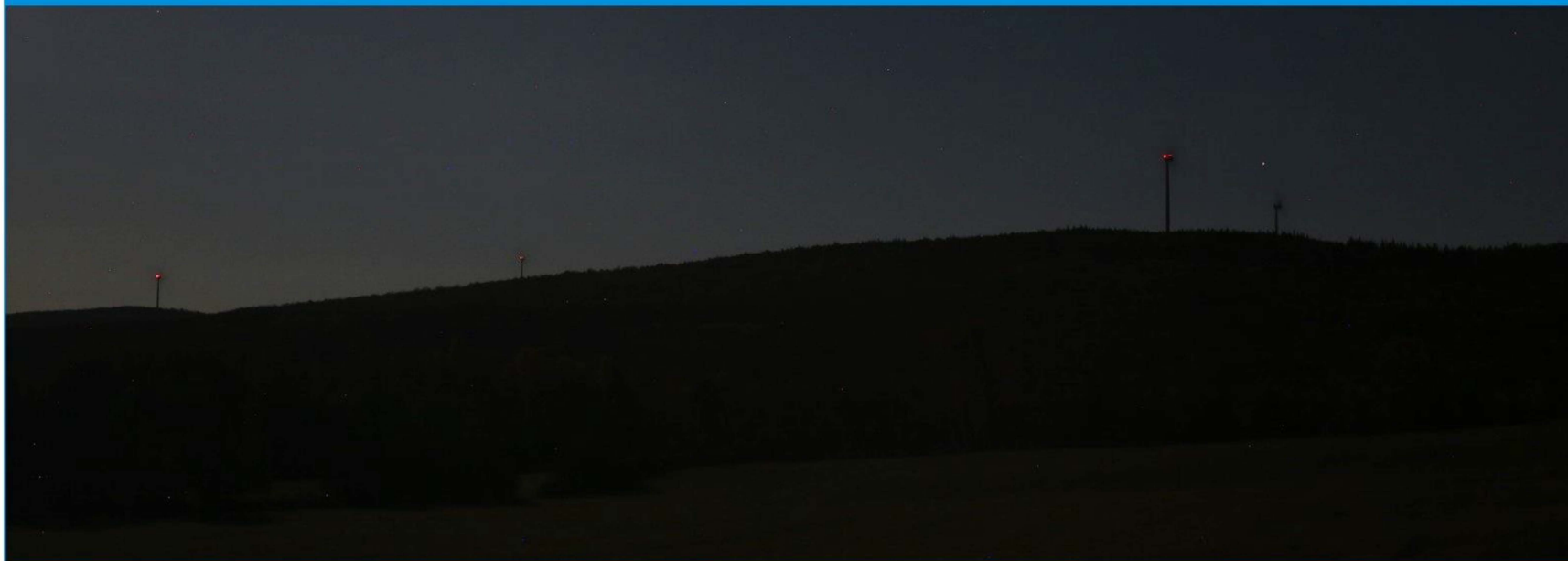
Parc éolien utilisant le balisage lumineux standard (2000 Candela – balises CL-864)
