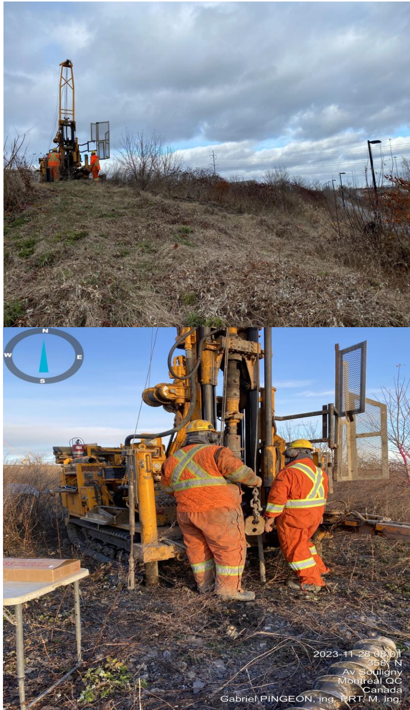
Photo 1 Début des travaux forage F-01-23
