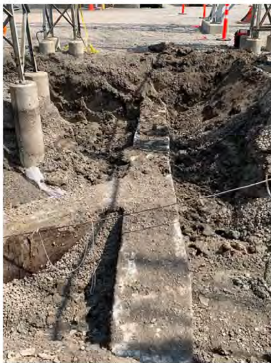
Photographie 10 Excavation – Excavation 2 (2 e secteur)
