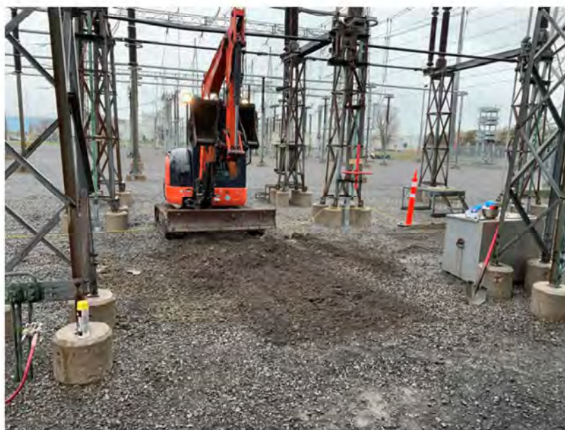
Photographie 2 Excavation Tranchée exploratoire TR-2
