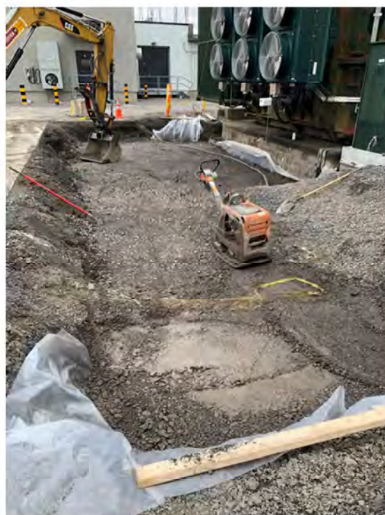
Photographie 8 Remblayage – Excavation 1
