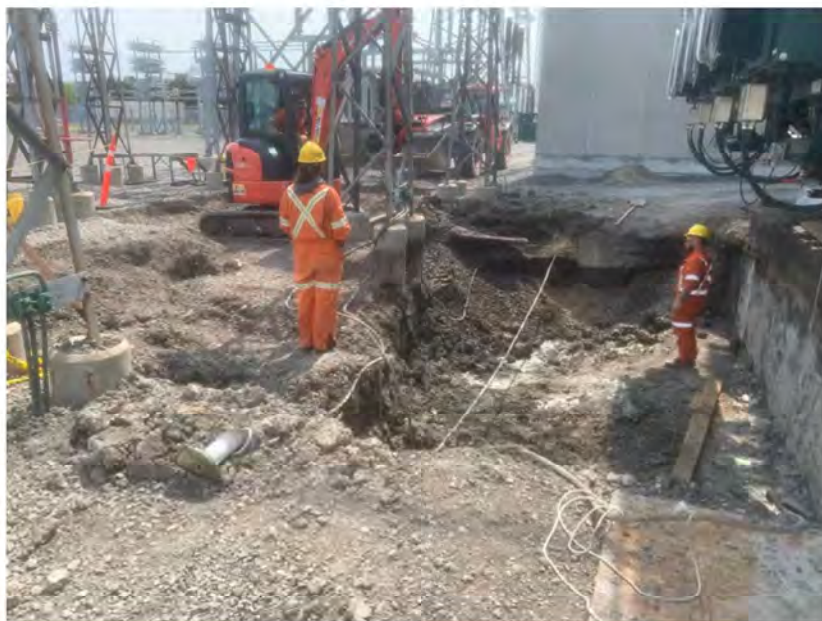
Photographie 9 Excavation – Excavation 2
