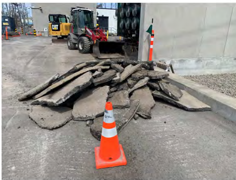
Photographie 7 Empilement de l'asphalte retirée – Excavation 1
