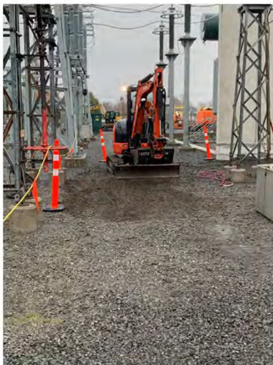
Photographie 1 Excavation Tranchée exploratoire TR-1
