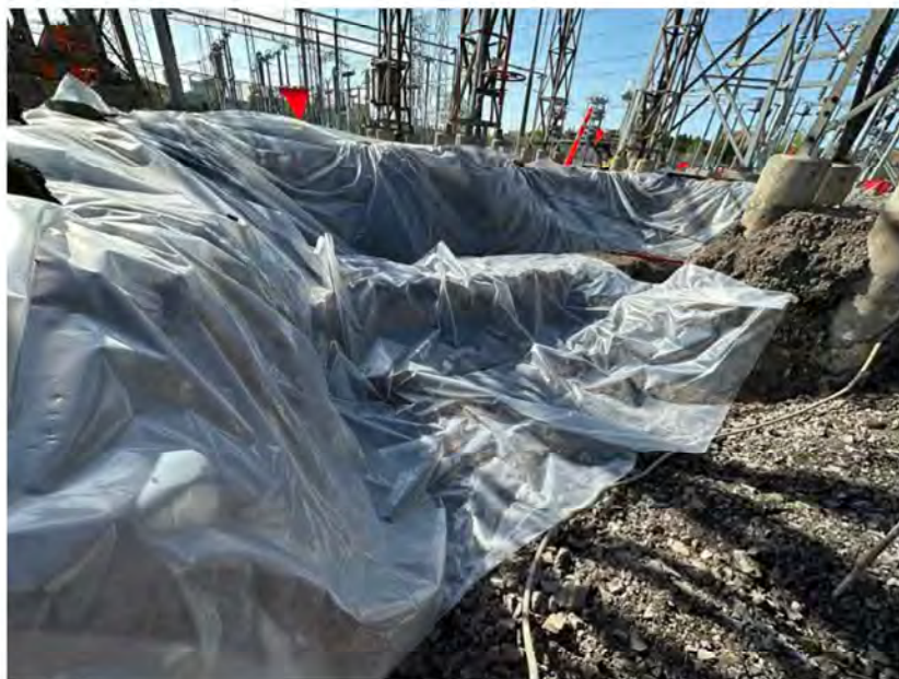
Photographie 11 Remblayage – Excavation 2
